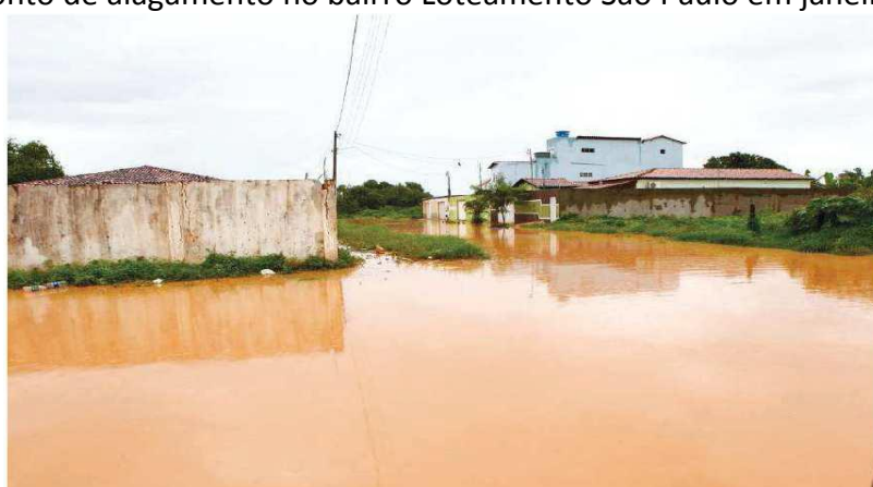
Figura 10 – Ponto de alagamento no bairro Loteamento São Paulo em janeiro de 2016.
