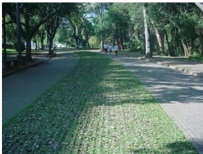
Figura 5 – Utilização de pavimentos porosos combinados com gramas, usados em espaços públicos.
