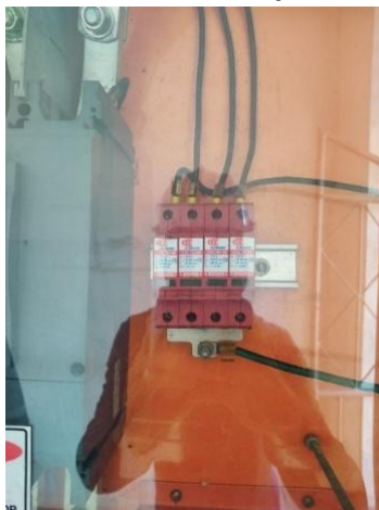
Figura 38 – DPS Classe II existente no QDC de entrada do Campus
