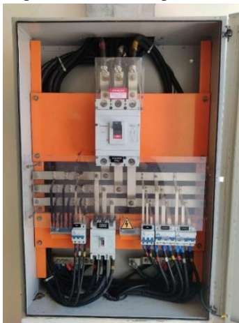
Figura 39 – QDC suplementar do Campus sem a existência de DPS
