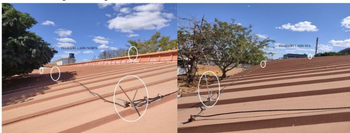
Figura 32 – Algumas hastes existentes no telhado do módulo laboratorial
