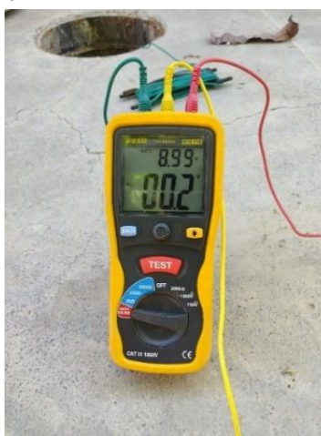
Figura 50 – Tensão de aterramento sendo medida.
