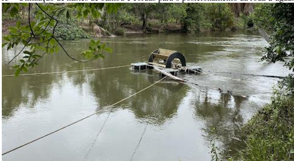
Figura 13 – Utilização de hastes de bambu e cordas para o posicionamento da roda d'água.
