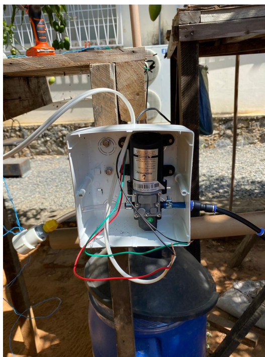
Figura 12 – Montagem sistema de bombeamento
