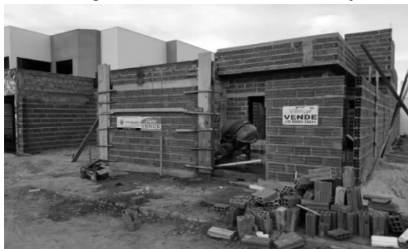
Figura 10 – Obra em fase de construção
