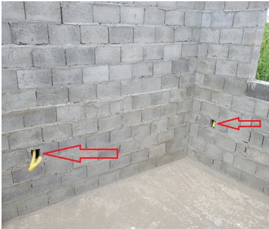
Figura 17 - Recortes realizados nos blocos para acomodar as caixas de luz 4x2 polegadas.
