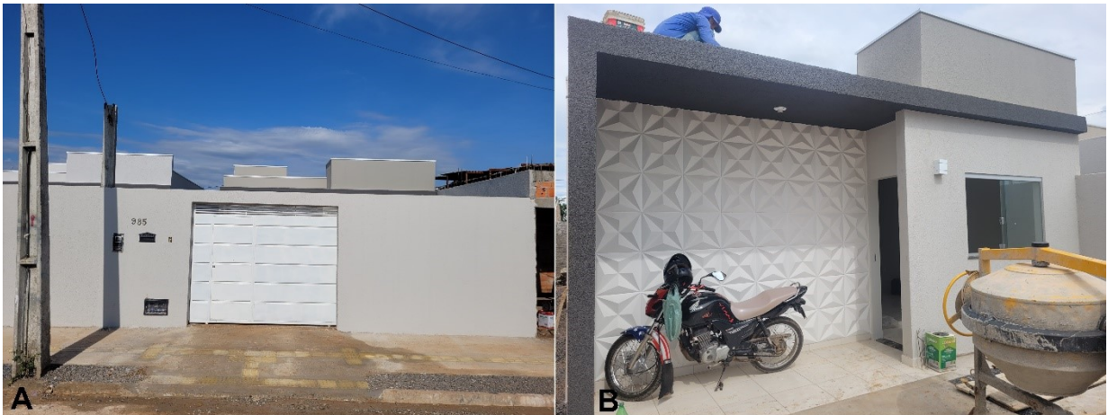
Figura 20 - Residência em alvenaria estrutural, analisada, sendo “A” fachada externa e “B” fachada interna
