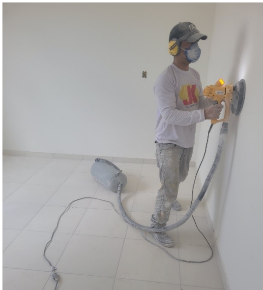
Figura 19 - Pintor lixando a parede com auxílio de máquina lixadeira elétrica
