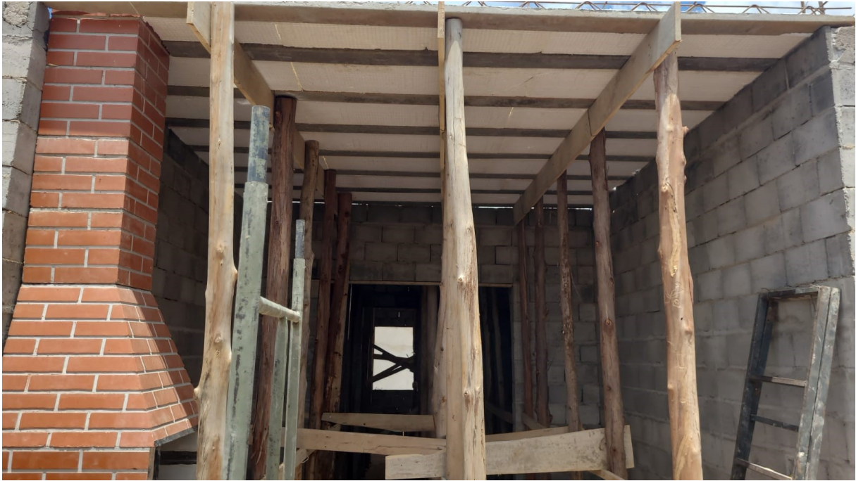
Figura 18 - Escoramento da laje com madeiras de eucalipto e tábuas de pinho.
