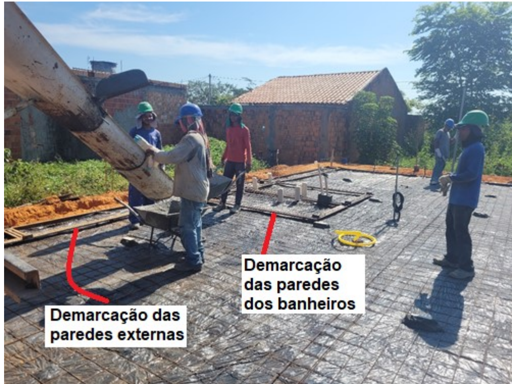
Figura 16 - Radier em processo de concretagem
