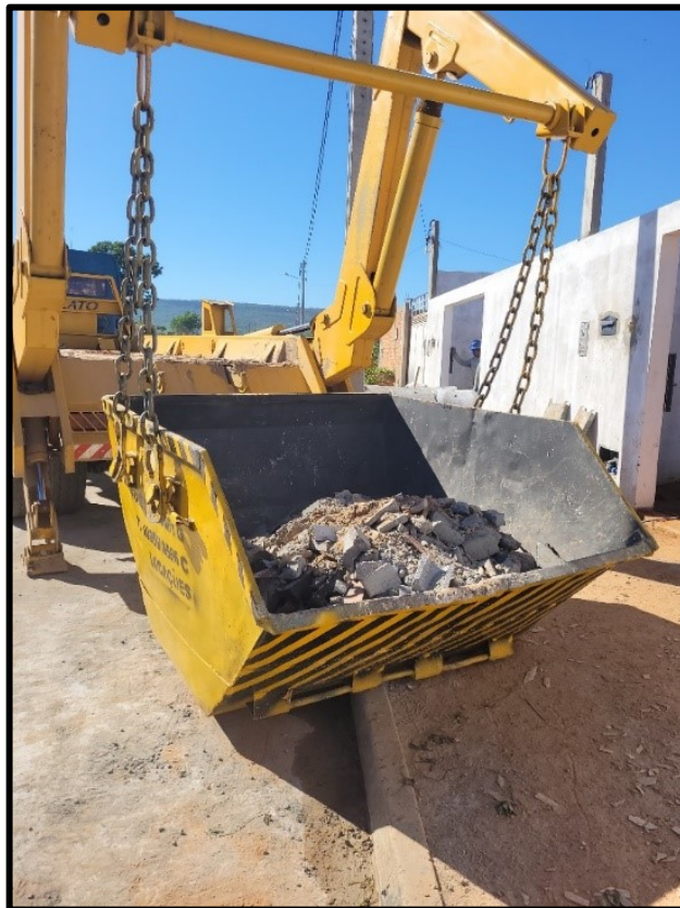
Figura 26 - Resíduos da obra que emprega alvenaria estrutural
