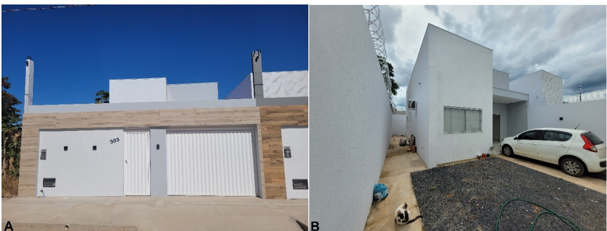
Figura 25 - Residência em alvenaria de vedação, analisada, sendo “A” fachada externa e “B” fachada interna
