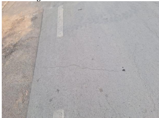
Figura 17 - Trinca Transversal
