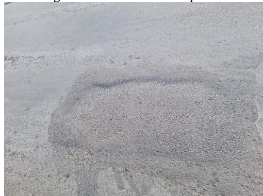
Figura 18 - Remendo com panela
