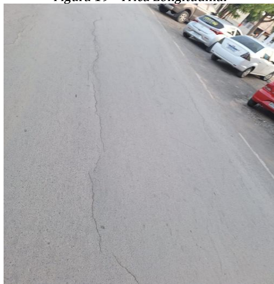
Figura 19 - Trinca Longitudinal
