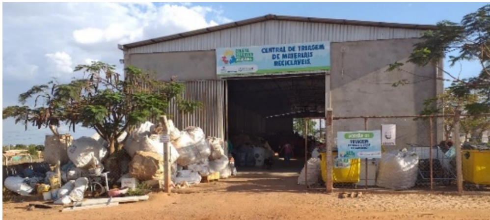
Figura 26 – Vista frontal do galpão
