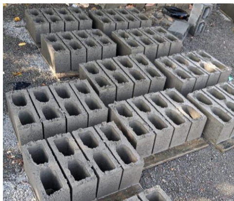
Figura 15: Armazenagem dos blocos.
