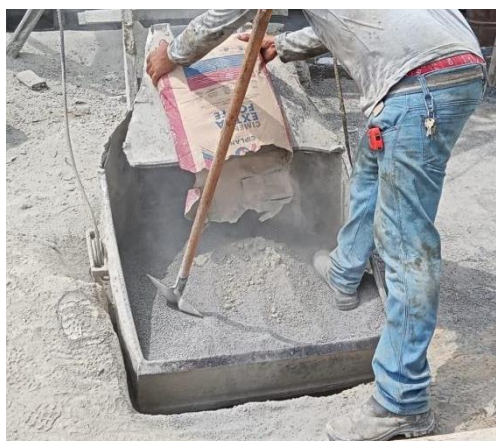
Figura 9: Colocação dos materiais na máquina.
