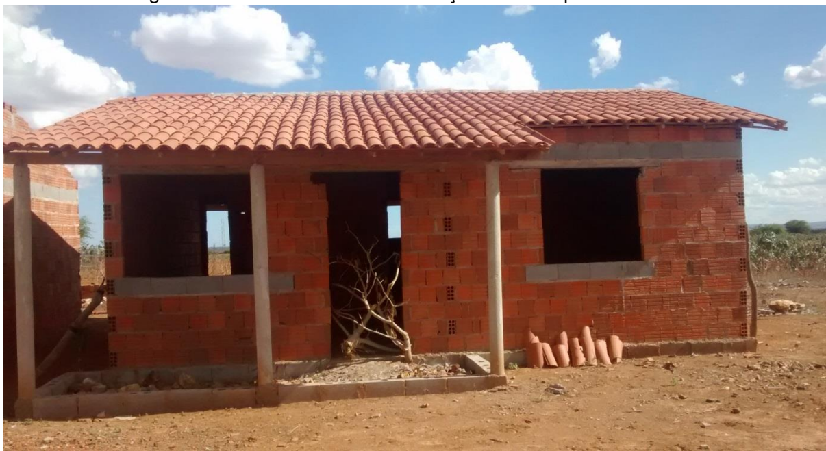
Figura 7: Residência Modelo em Execução no Município de Ibititá-BA.
