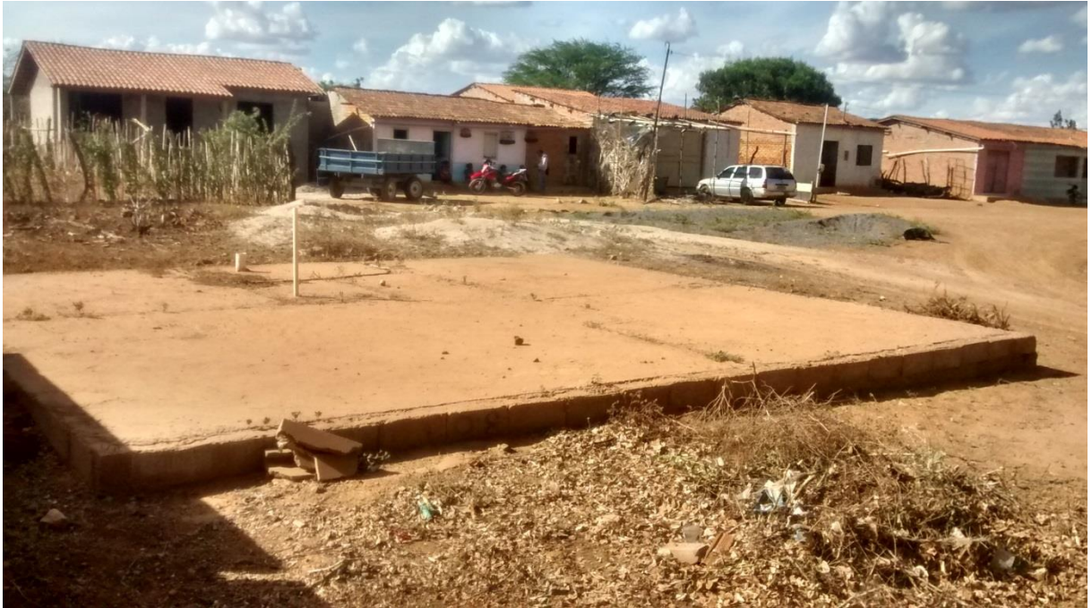
Figura 5: Residência Modelo em Execução no Município de Ibititá-BA.
