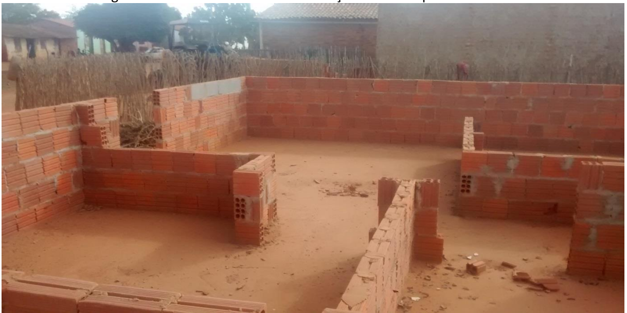
Figura 6: Residência Modelo em Execução no Município de Ibititá-BA.
