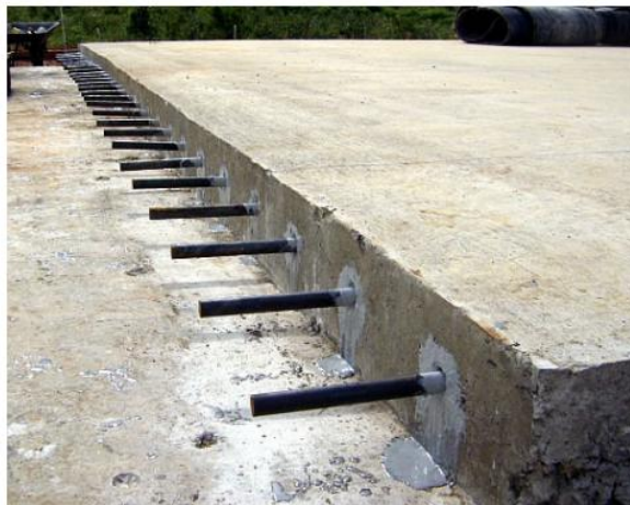
Figura 6 - Junta de Construção com barras de transferência após desforma
