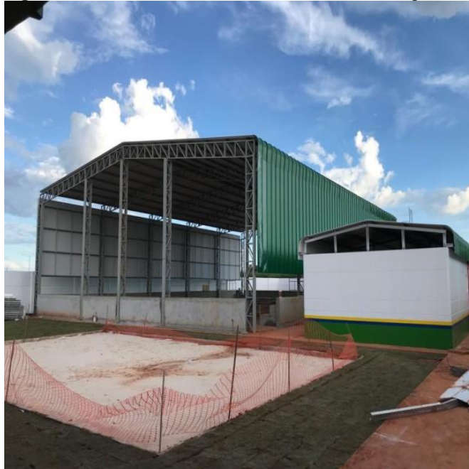
Figura 1 - Fechamento Lateral com telha metálica trapezoidal
