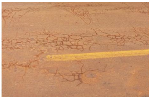
Figura E 5 - Painelas e remendos (TCP).
