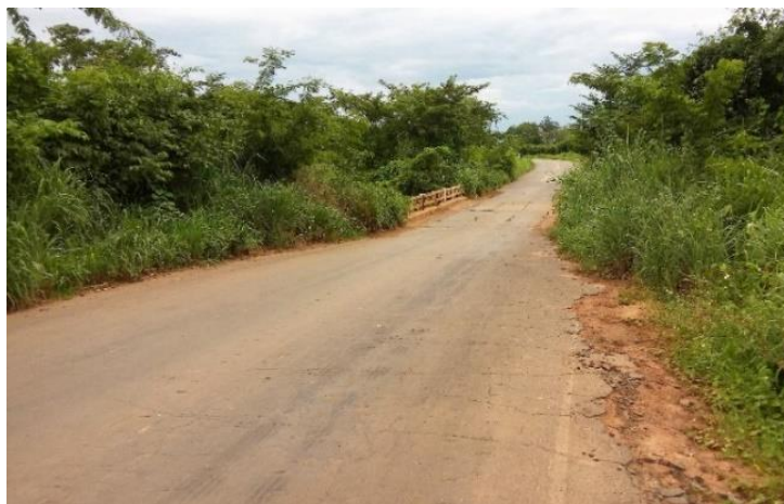
Figura 33 – Ponte que possibilita a passagem de um veículo por vez.
