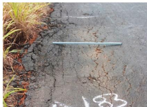
Figura E 8 - Afundamento na trilha de roda (TCP).
