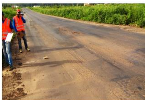
Figura E 8 - Afundamento na trilha de roda (TCP).
