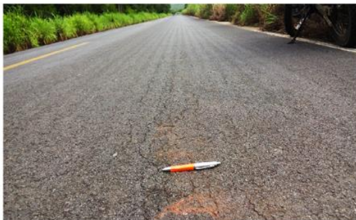
Figura E 3 - Trinca interligada tipo jacaré (TCP).
