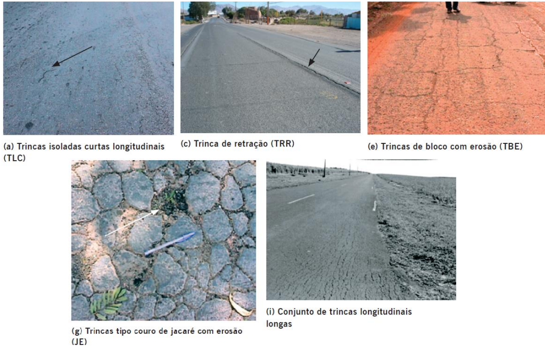
Figura 6 – Exemplos de fendas.
