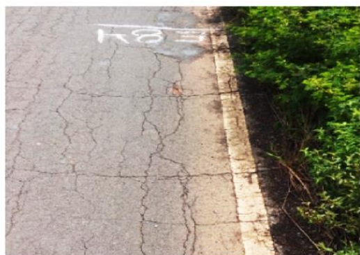
Figura E 7 - Trincas interligadas e transversais (TCP).
