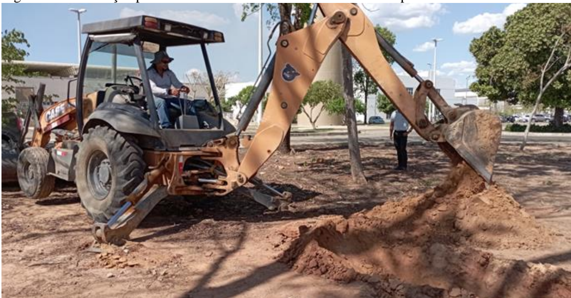
Figura 15 – Escavação para coleta de amostra indeformada auxiliada por retroescavadeira.
