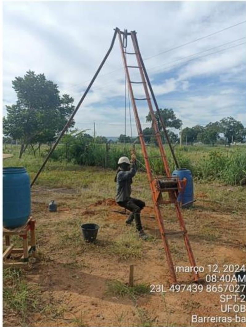
EXECUÇÃO EM CAMPO
