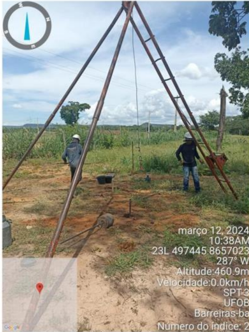
EXECUÇÃO EM CAMPO
