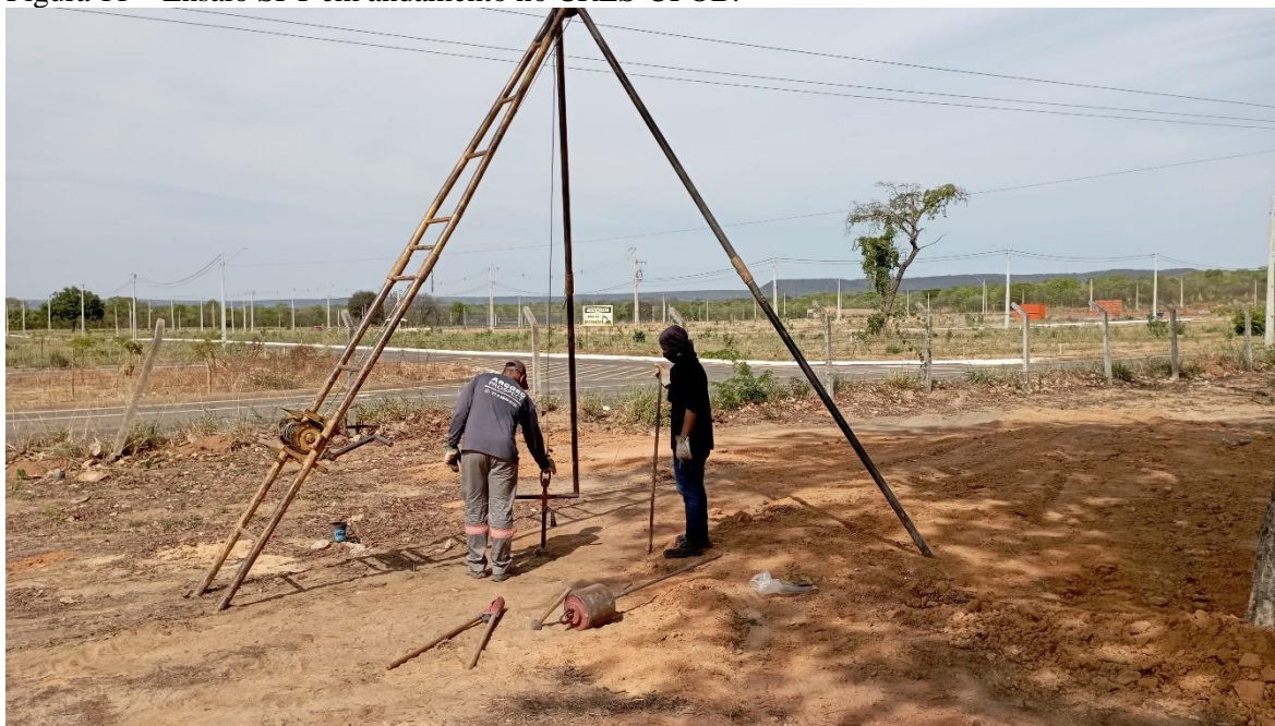
Figura 11 – Ensaio SPT em andamento no CRES-UFOB.
