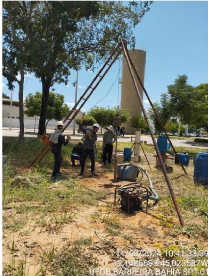
EXECUÇÃO EM CAMPO
