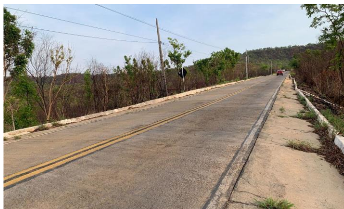
Figura 21: Início do trecho de pavimento rígido na Rodovia BA-826.
