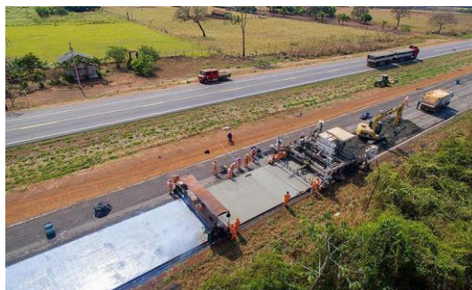
Figura 7: Processo de Whitetopping.
