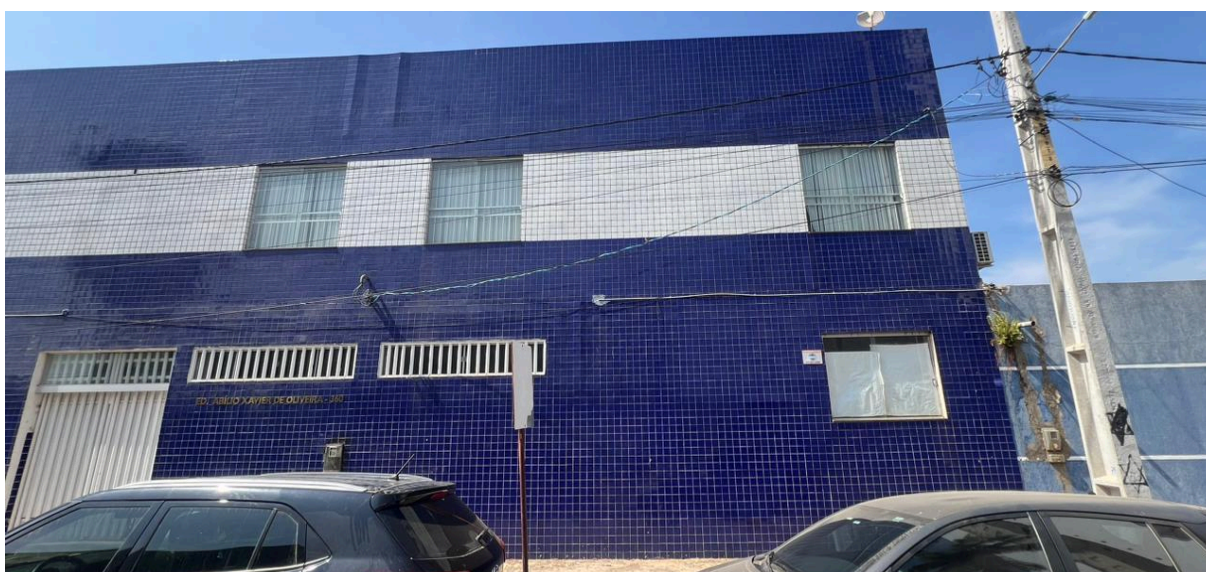
Figura 38 – Vista da Fachada 2
