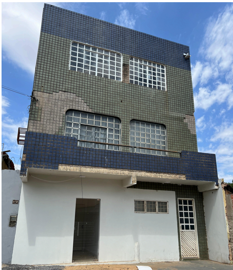
Figura 35 – Vista da Fachada 1
