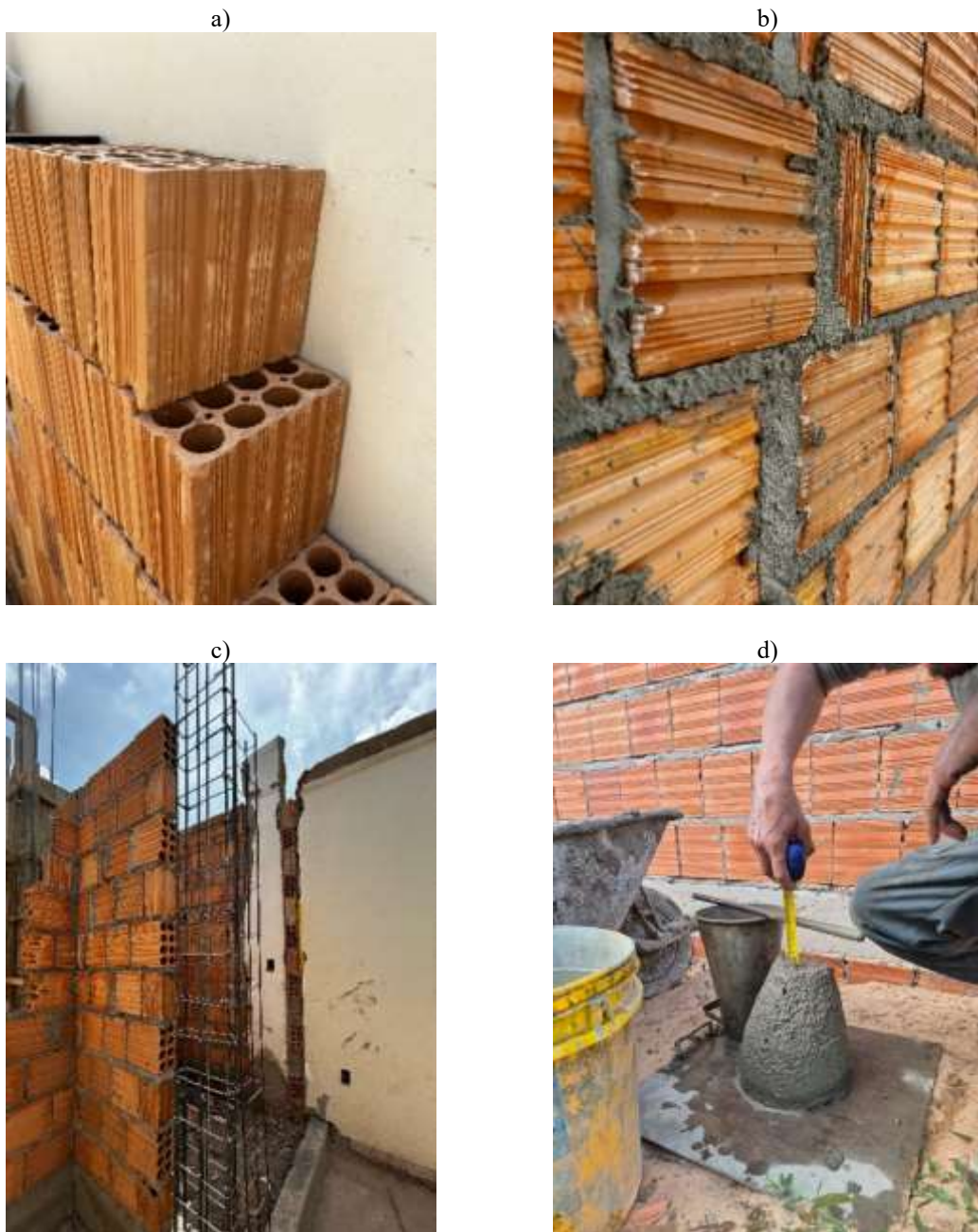
Figura 6 – Componentes da ACBC a) Bloco cerâmico; b) Argamassa de assentamento; c) Armadura; d) Concreto
