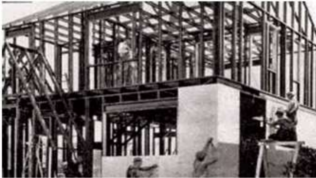
Figura 2 – Protótipo de residência em LSF exposta em 1933.
