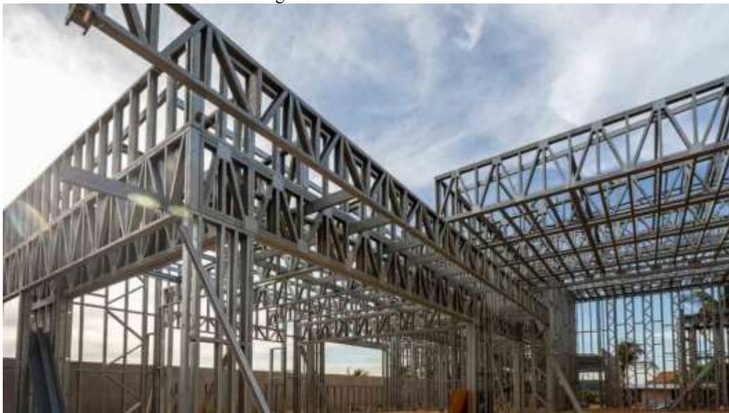
Figura 1 – Estrutura em LSF.
