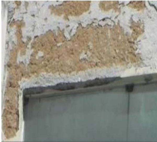
Figura 6- Descolamento com pulverulência
