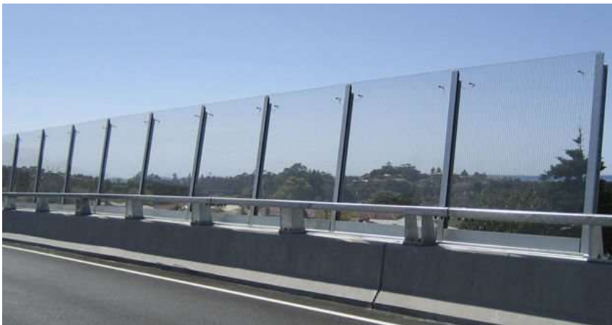
Figura 6- Barreira acústica com acrílico incolor
