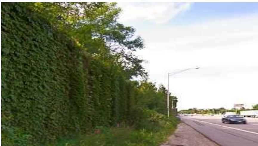
Figura 7- Barreira acústica com vegetação
