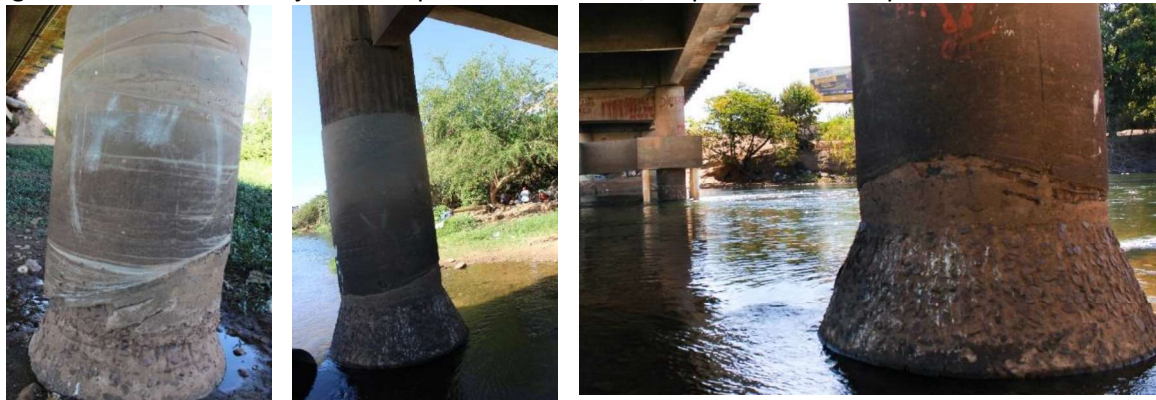
Figura 64 – Pilares do conjunto de apoio intermediário, no primeiro vão da ponte.
