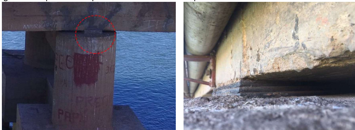
Figura 51 – Aparelho de apoio elastomérico sobre os pilares.
