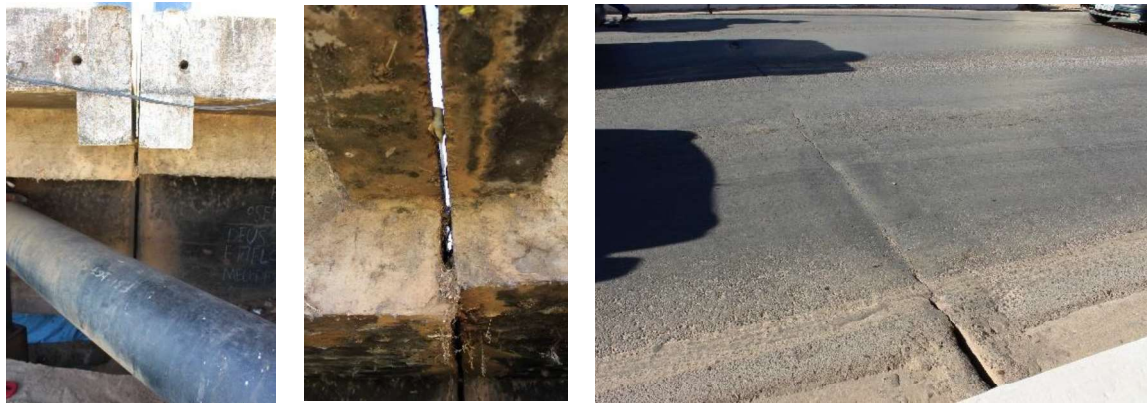
Figura 50 – Junta de dilatação entre a cabeceira da ponte e o viaduto de acesso.
