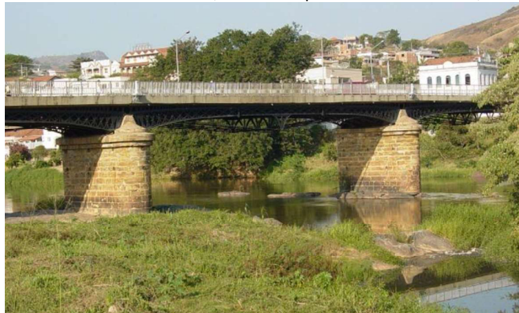
Figura 3 – Ponte sobre o Rio Paraíba do Sul, no município de Paraíba do Sul, RJ.
