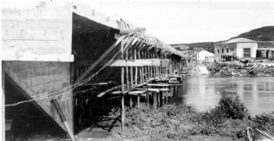
Figura 43 - Obra da ponte sobre o Rio Grande, na cidade de Barreiras/BA, na década de 1960.
