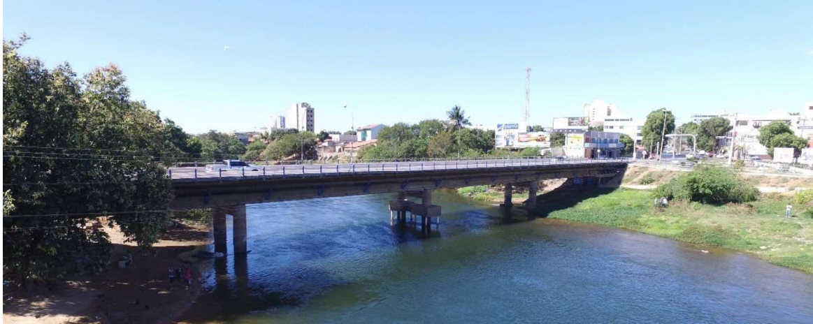
Vista longitudinal da ponte sobre o Rio Grande
