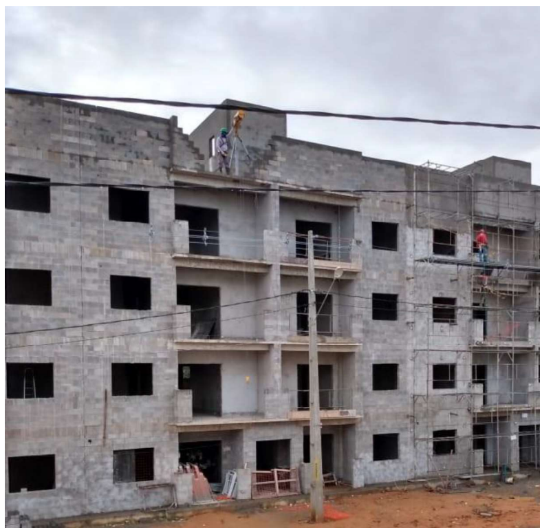
Figura 1 - Edificação construída com o sistema de alvenaria estrutural.
