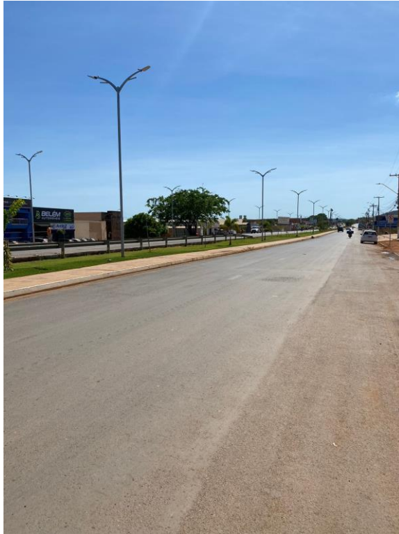
Figura 27 – Pavimento da avenida ACM.
