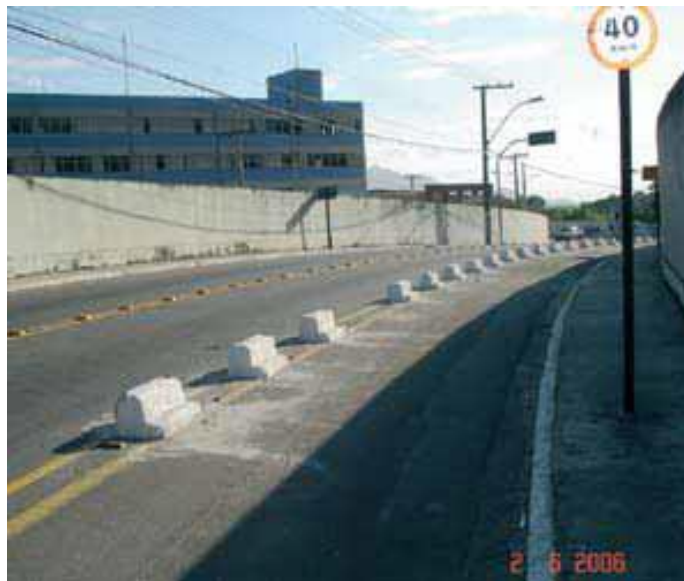
Figura 7 - Ciclovía segregada junto à via.
