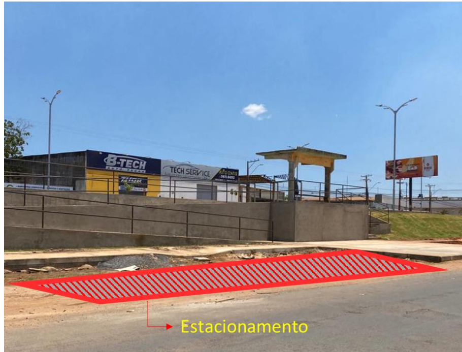
Figura 25 – Futuro estacionamento na Avenida Clériston Andrade.
