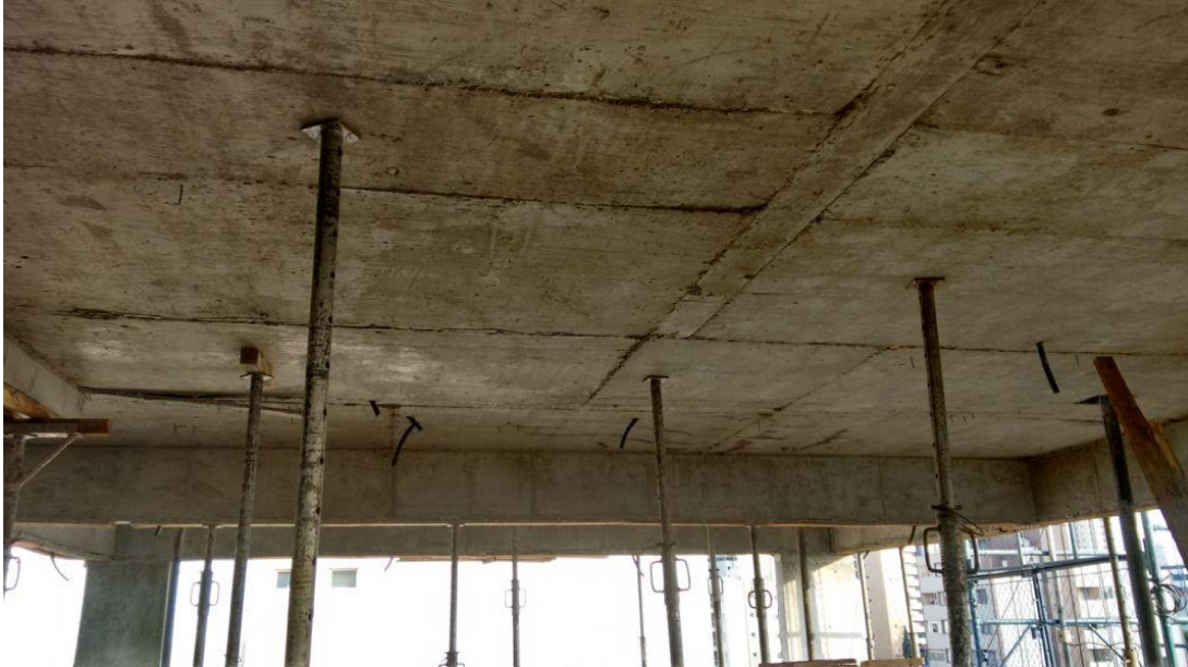
Figura 12 - Laje maciça convencional reescorada
