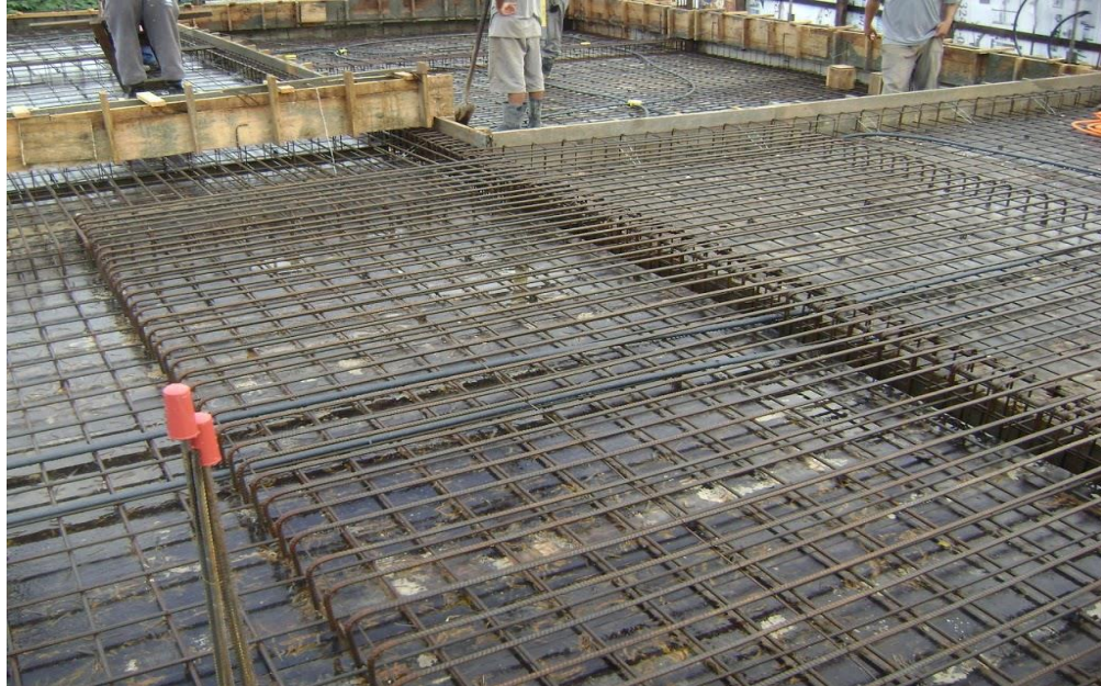
Figura 10 - Execução de laje maciça convencional de concreto armado
