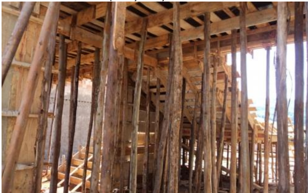
Figura 11 - Escoramento de madeira para laje maciça convencional
