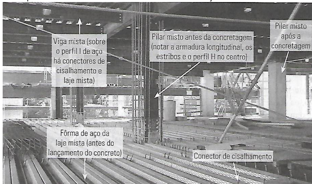
Figura 2- Exemplo de obras com elementos estruturais mistos de aço e concreto.
