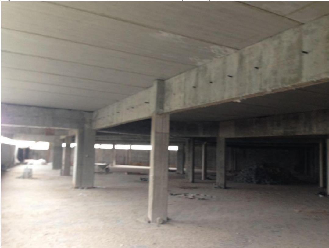
Figura 13 - Pavimento de edifício executado em laje maciça convencional.
