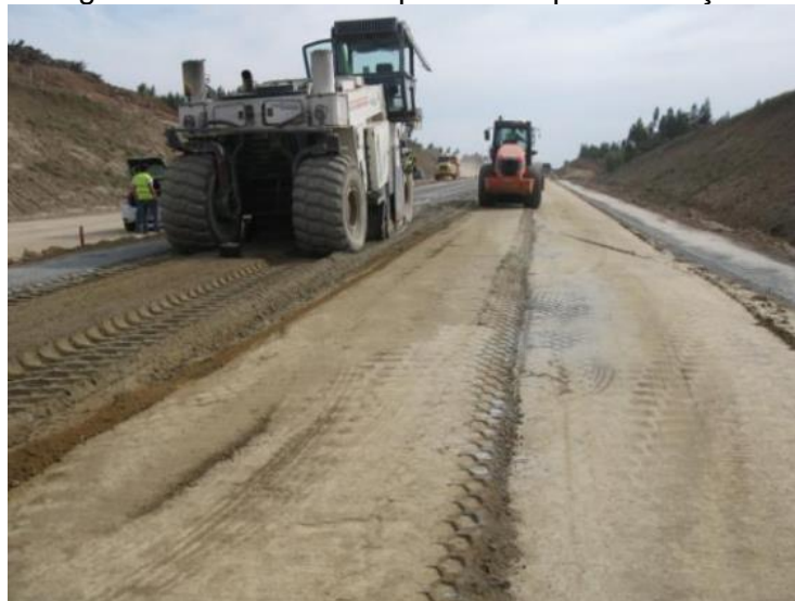
Figura 3. Solo-cimento aplicado na pavimentação.
