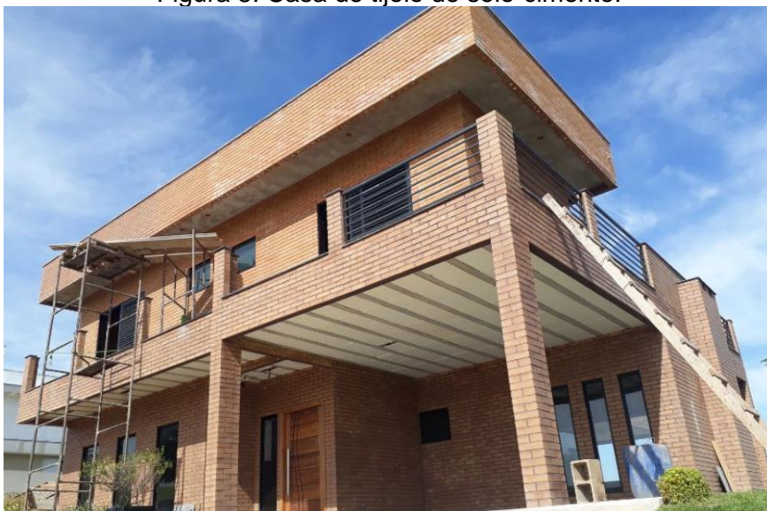
Figura 5. Casa de tijolo de solo-cimento.
