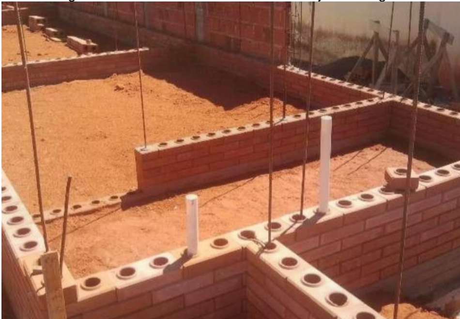
Figura 7. Levantamento de alvenaria de tijolo ecológico.
