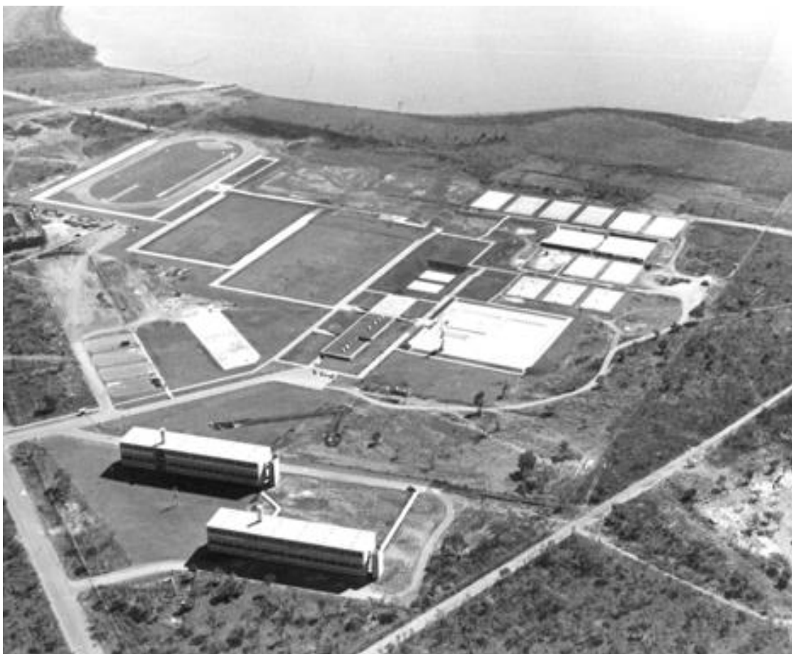
Figura 20 - Vista aérea do Centro Olímpico e Alojamentos – UnB.
