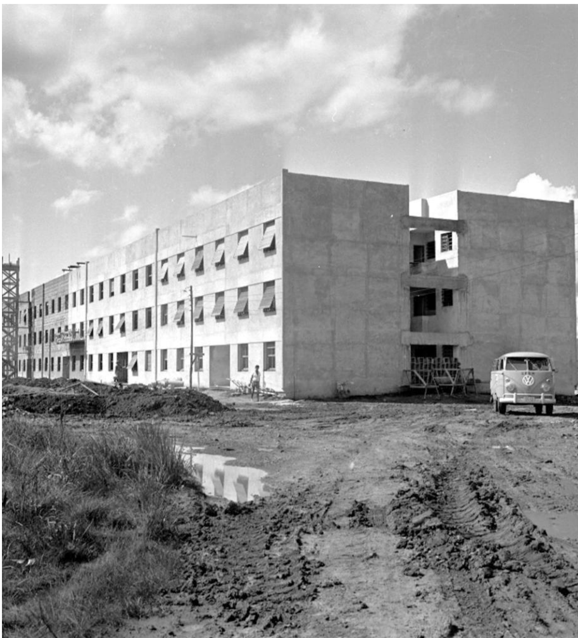
Figura 13 – CEU II nos tempos de construção.
