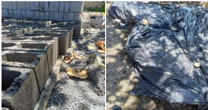
Figura 15- Cura Inicial dos Blocos de Concreto.
