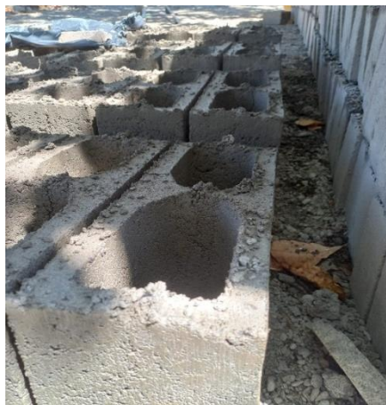
Figura 14 – Armazenamento e início da cura dos Blocos de Concreto.
