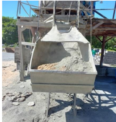
Figura 10 - Mistura dos agregados mais cimento.
