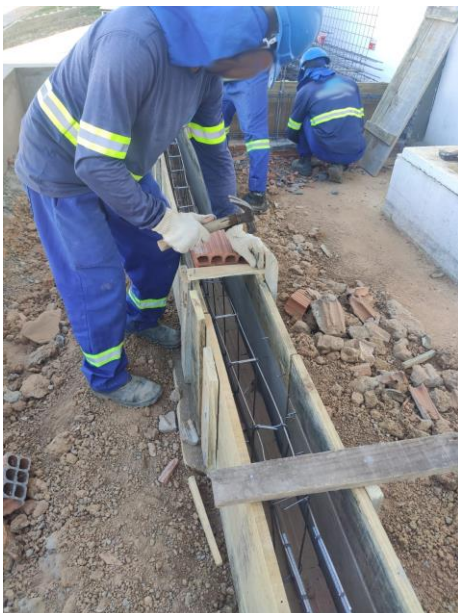
Figura 35 - Colaborador executando a fôrma da viga baldrame
