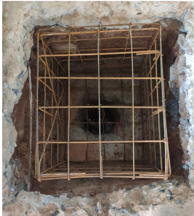
Figura 22 - Armadura posicionada para fundação
