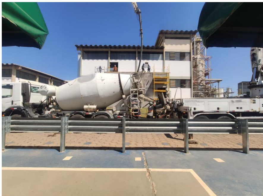
Figura 59 - Transporte do concreto a partir do caminhão betoneira e caminhão bomba
