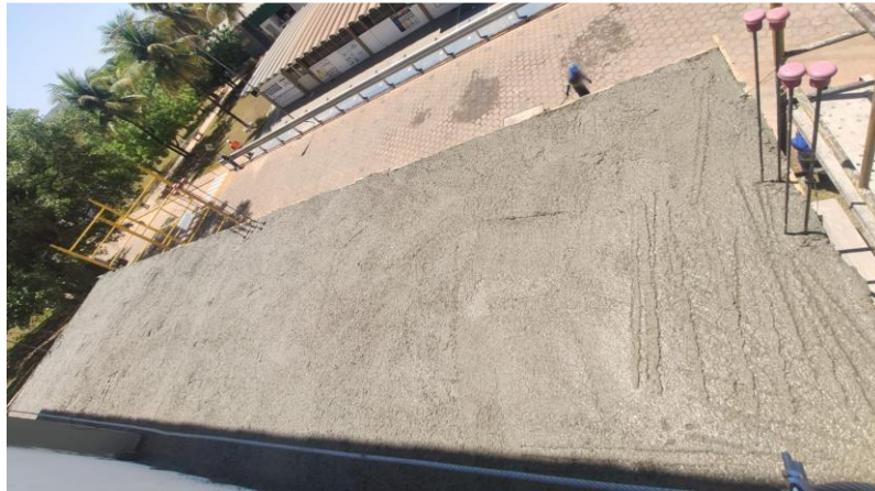
Figura 61 - Concreto lançado em laje
