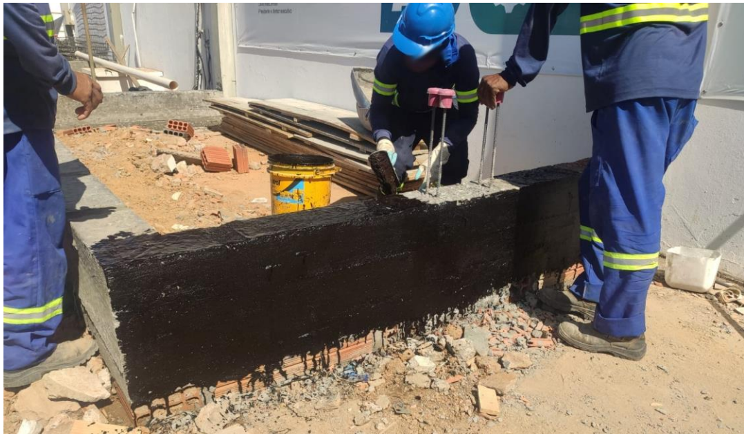
Figura 43 - Aplicação de impermeabilizante asfáltico
