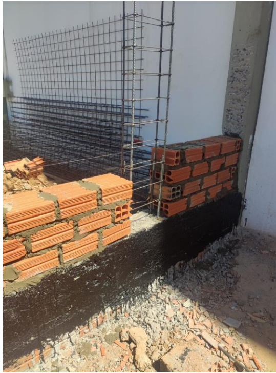
Figura 25 - Armadura de pilar posicionada
