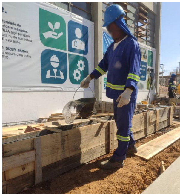
Figura 38 - Colaborador molhando as fôrmas internamente antes da concretagem
