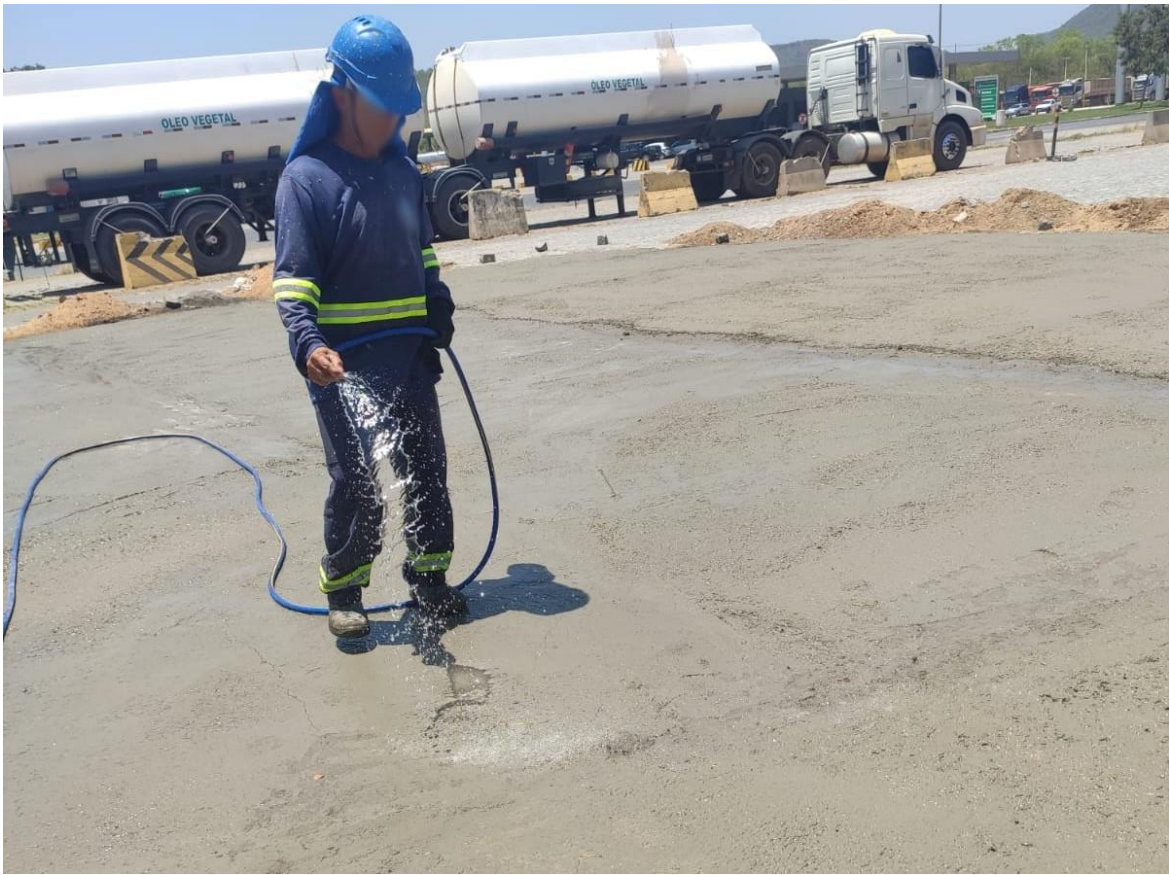
Figura 17 - Colaborador utilizando mangueira para realização da cura do concreto
