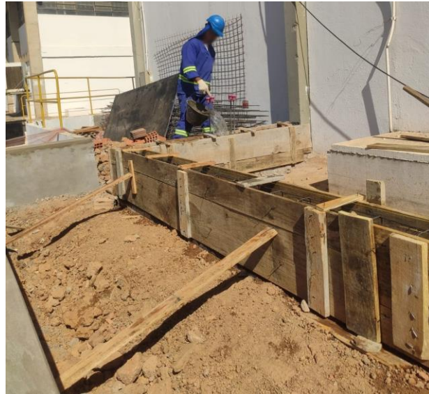
Figura 37 – Fôrmas de viga baldrame travadas lateralmente
