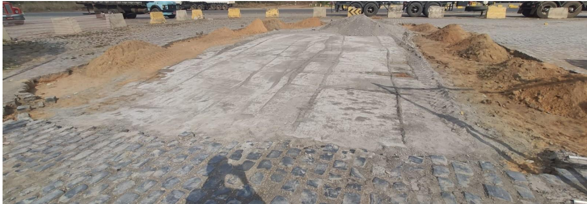
Figura 7 - Serviço preliminar para piso de concreto armado
