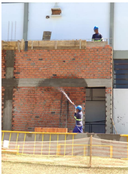
Figura 31 - Colaborador utilizando a mangueira para cura do concreto
