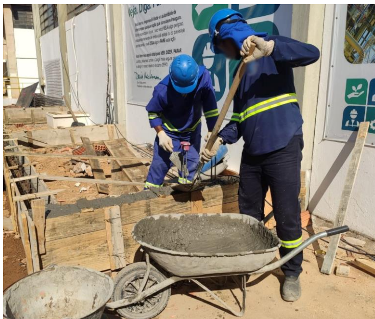
Figura 40 - Concreto lançado com auxílio de pá e colher de pedreiro
