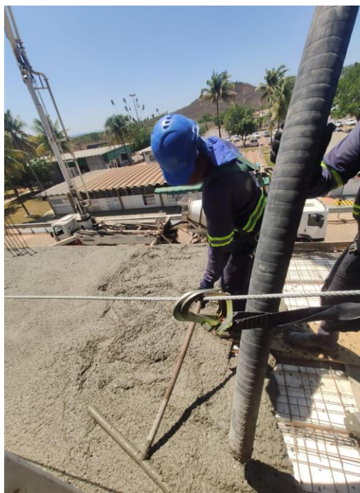
Figura 62 – Espalhamento e adensamento do concreto com auxílio de "rodo"
