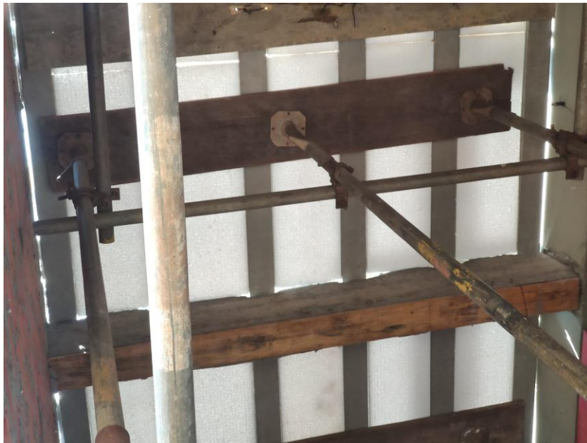
Figura 55 - Detalhe do escoramento com andaime tubo roll (respeitando o espaçamento)
