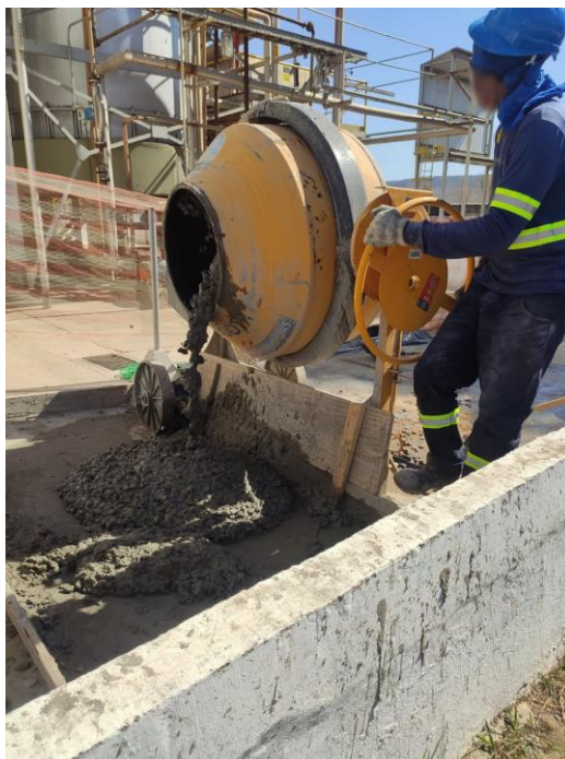
Figura 39 - Concreto confeccionado em betoneira
