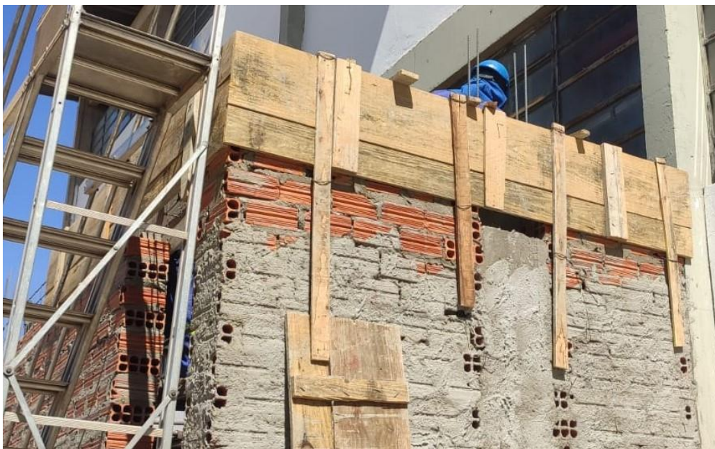
Figura 47 - Fôrmas de viga travadas lateralmente
