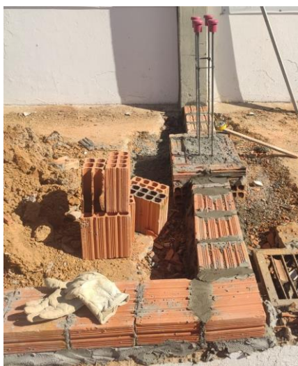
Figura 33 - Fundo de viga baldrame com alvenaria
