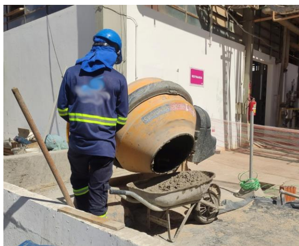
Figura 28 - Concreto confeccionado em betoneira e transportado em carrinho de mão
