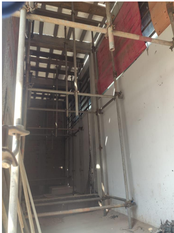
Figura 54 - Escoramento de laje com andaime tubo roll
