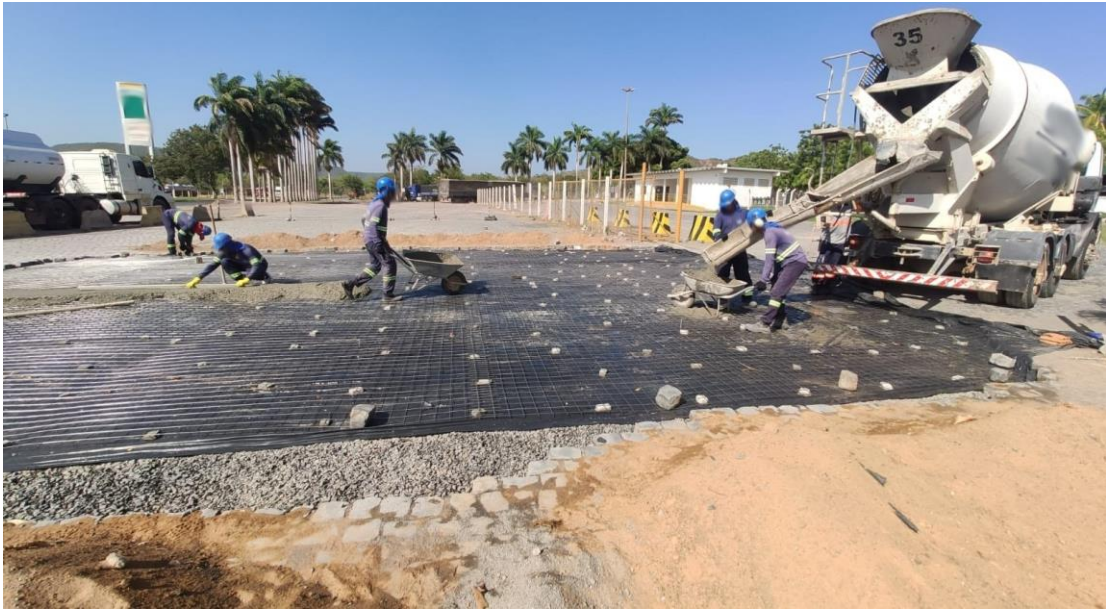
Figura 15 - Lançamento do concreto a partir de carrinhos de mão
