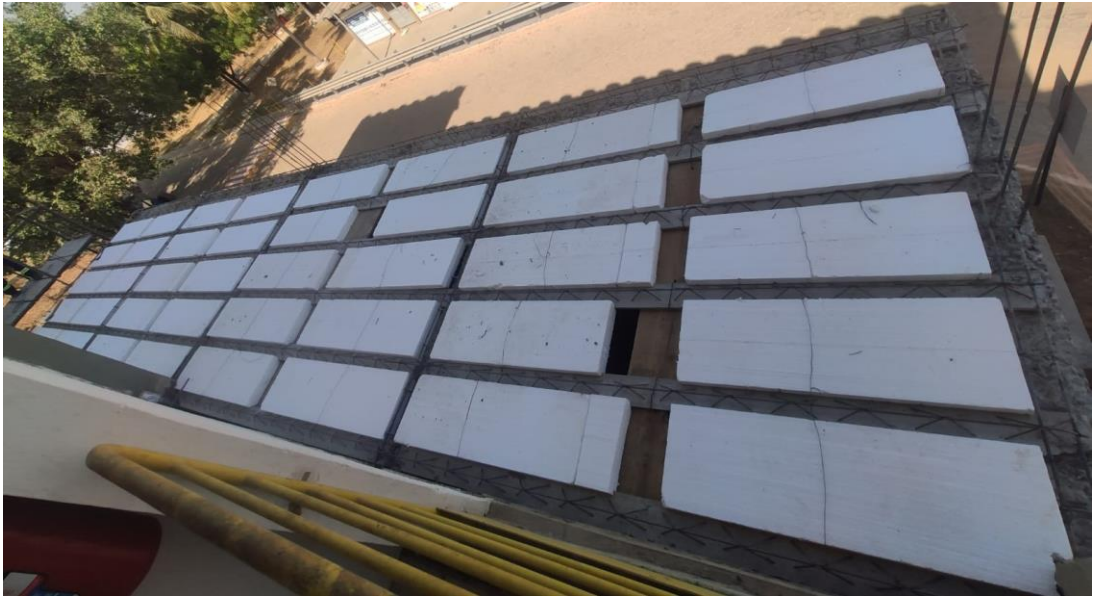
Figura 53 - Vigotas e EPS colocados de acordo projeto estrutural
