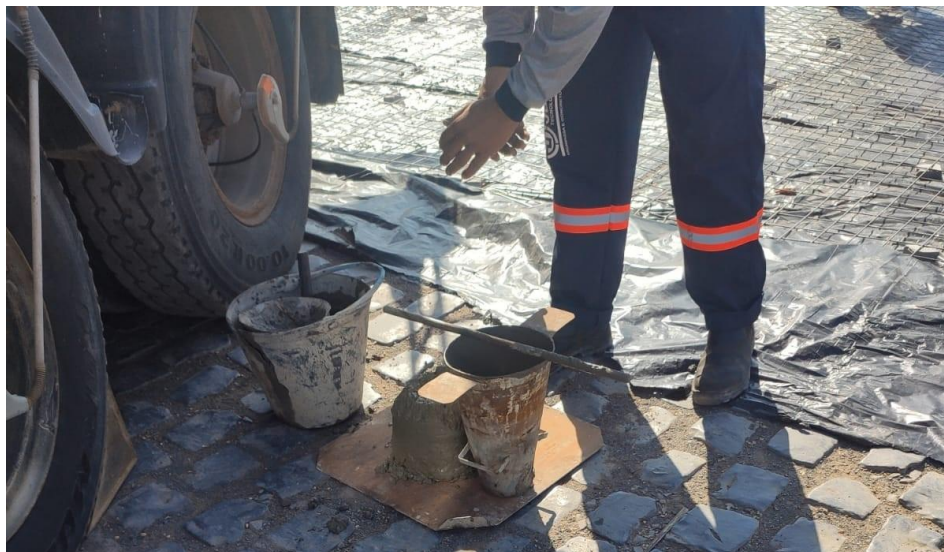
Figura 13 - Colaborador da concreteira realizando o ensaio de abatimento do concreto
