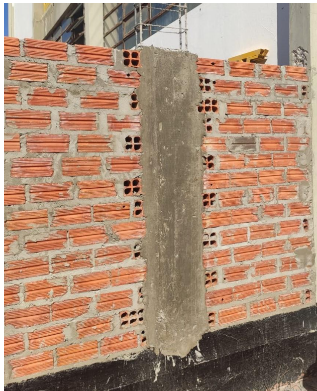
Figura 32 - Pilar após retirada da sua fôrma
