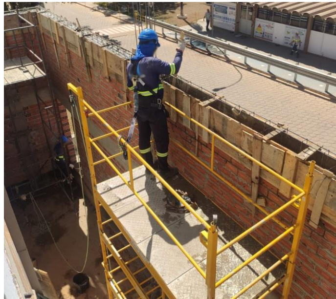
Figura 51 - Colaborador utilizando estaca de madeira para adensar concreto
