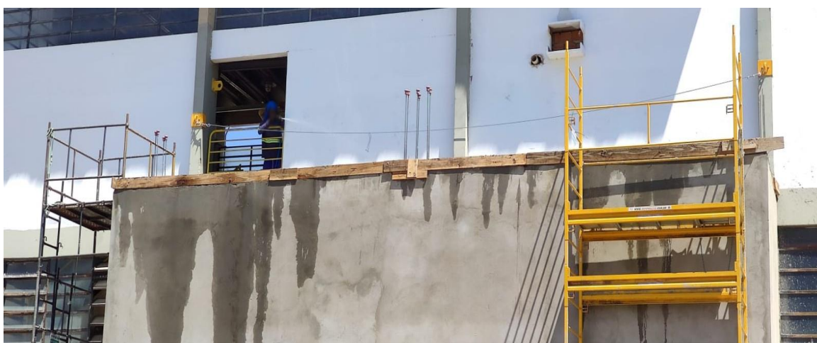
Figura 63 - Colaborador utilizando mangueira para a cura do concreto
