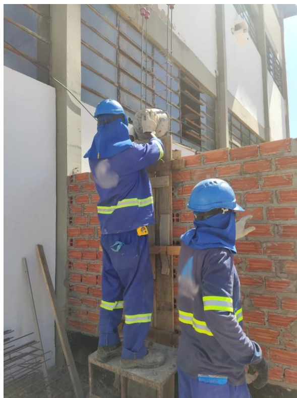
Figura 29 - Lançamento de concreto com balde
