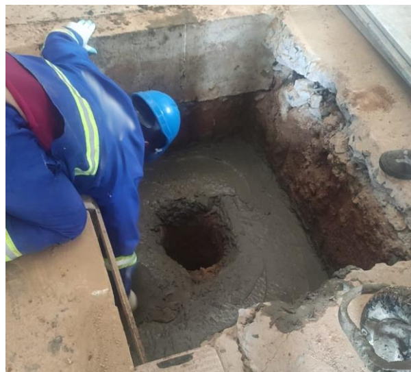
Figura 21 - Colaborador assentando o lastro de concreto magro
