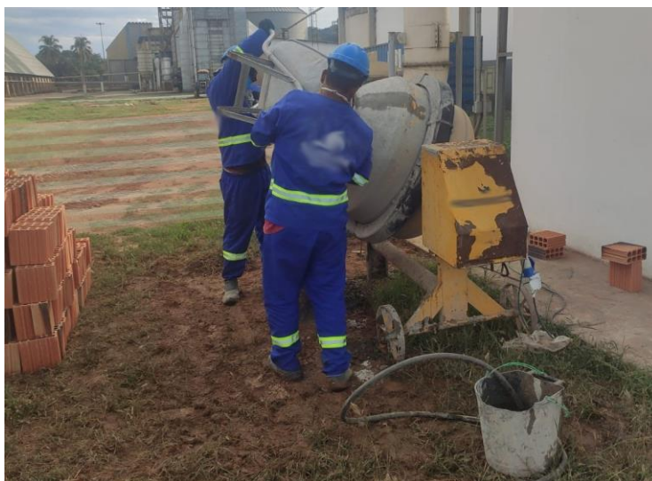
Figura 24 - Concreto confeccionado em betoneira e transportado em carrinho de mão
