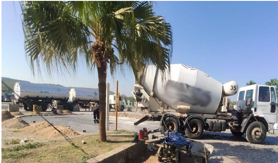
Figura 12 - Caminhão betoneira utilizado para concretagem do piso
