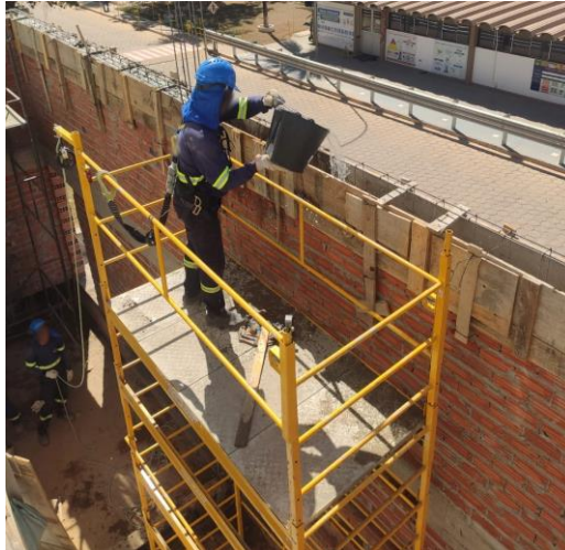
Figura 48 - Colaborador molhando a fôrma internamente antes da concretagem
