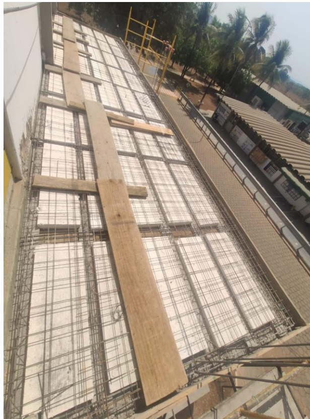
Figura 56 - Telas de aço instaladas de acordo projeto estrutural
