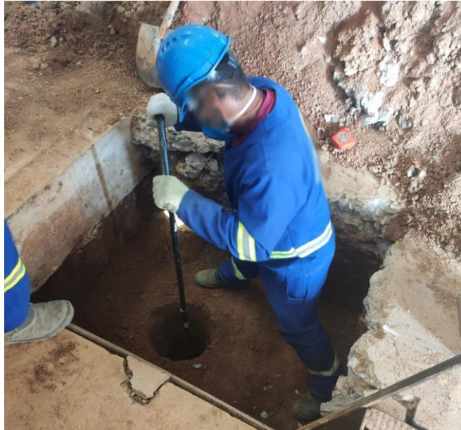
Figura 20 - Colaborador realizando escavação para fundação
