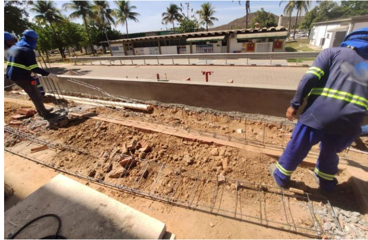
Figura 34 - Posicionamento de armadura da viga baldrame
