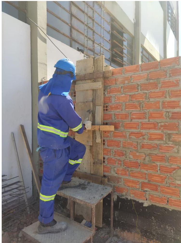
Figura 30 - Colaborador utilizando o martelo para "adensar" o concreto
