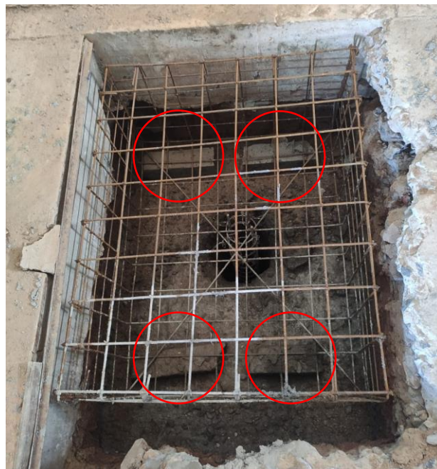
Figura 23 - Espaçamento utilizado entre lastro de concreto e armadura
