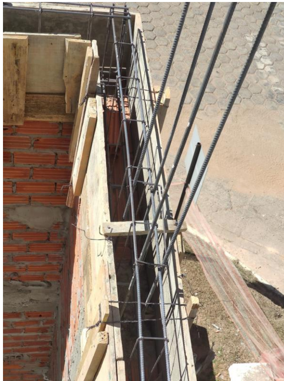
Figura 44 - Armadura da viga posicionada de acordo projeto estrutural
