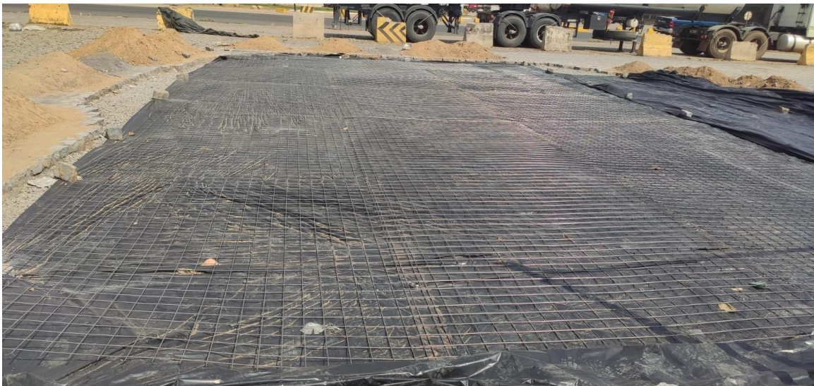
Figura 9 - Camada separadora de lona plástica
