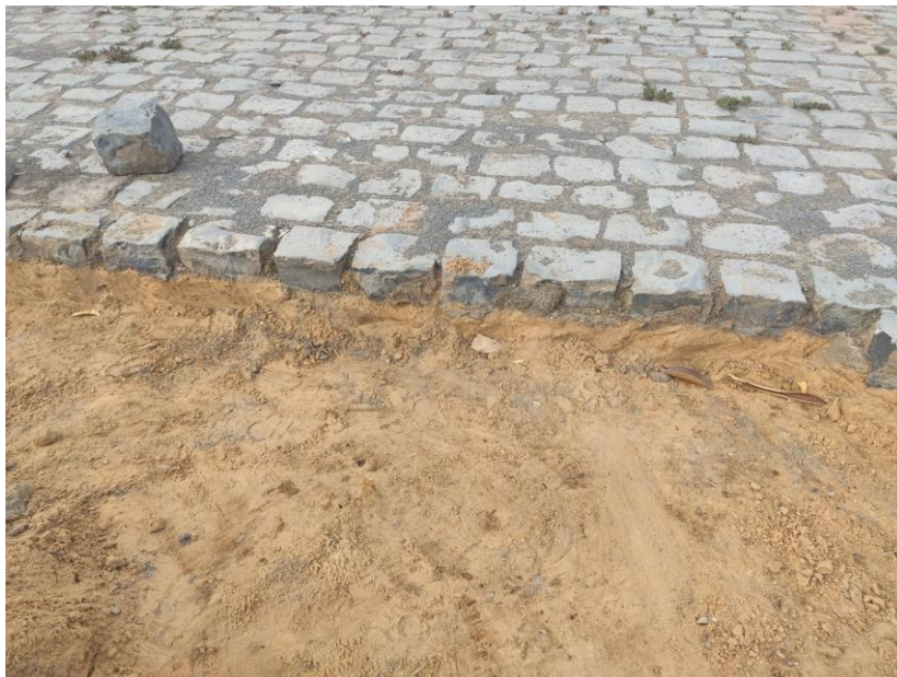
Figura 8 - Bloquetes utilizados como fôrma lateral para piso
