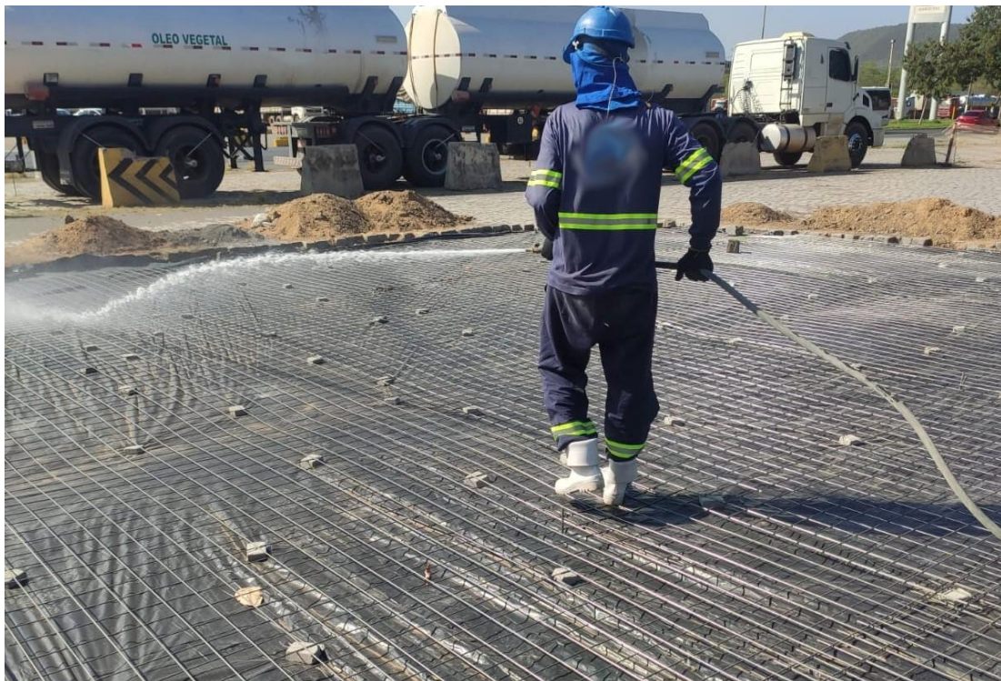
Figura 11 - Colaborador molhando o piso previamente à concretagem
