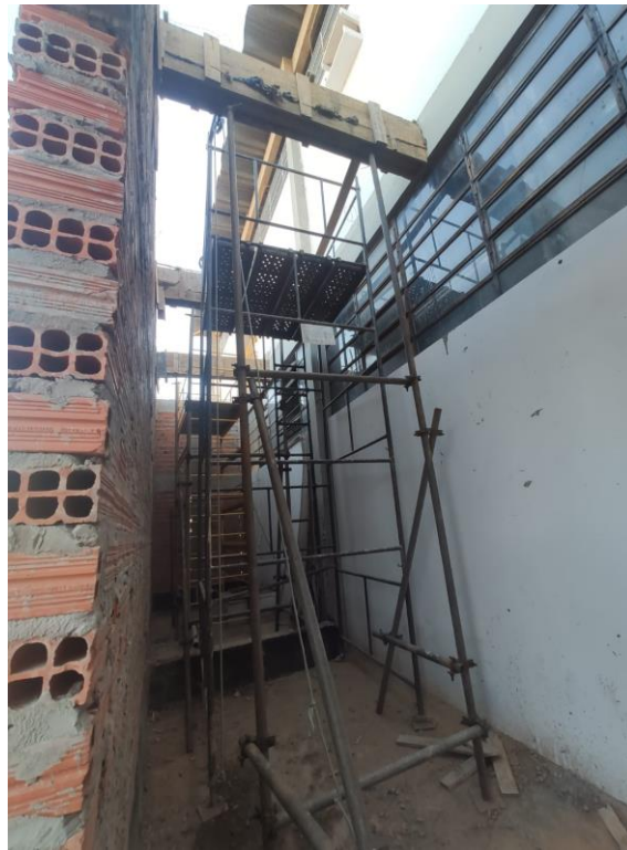
Figura 46 - Face de baixo de fôrma de viga e seu escoramento
