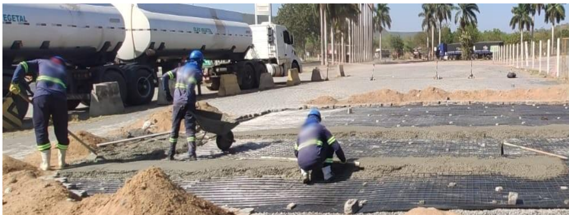
Figura 16 - Colaborador espalhando o concreto com "rodo"
