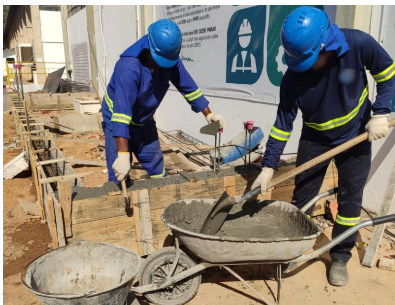
Figura 41 - Utilização do martelo na tentativa de adensamento do concreto
