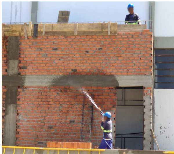
Figura 52 - Colaborador utilizando mangueira para cura do concreto
