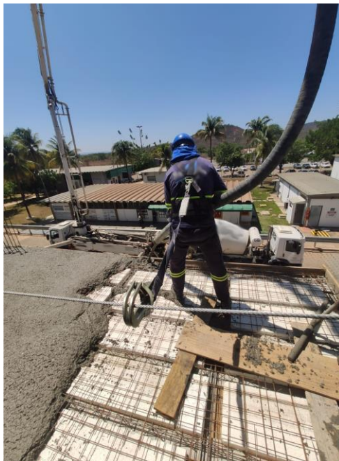
Figura 60 - Mangote na inclinação correta para lançamento de concreto
