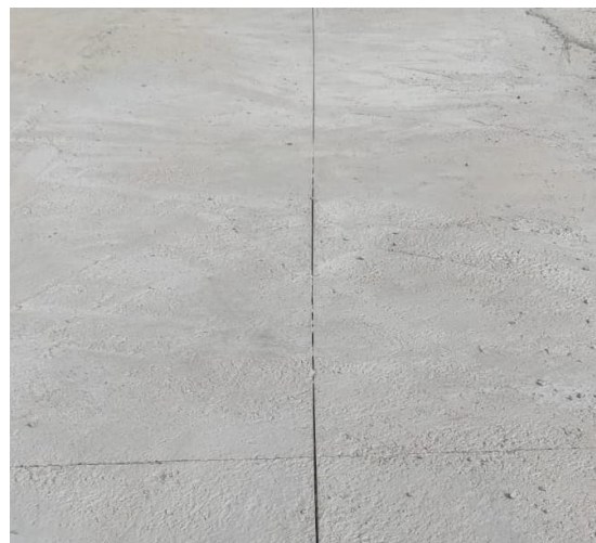
Figura 19 - Junta de dilatação após corte
