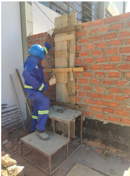
Figura 26 - Colaborador montando a fôrma parcial do pilar
