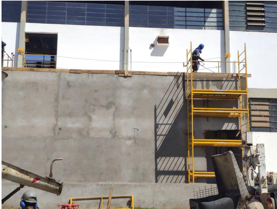
Figura 58 - Colaborador molhando a laje anteriormente à concretagem
