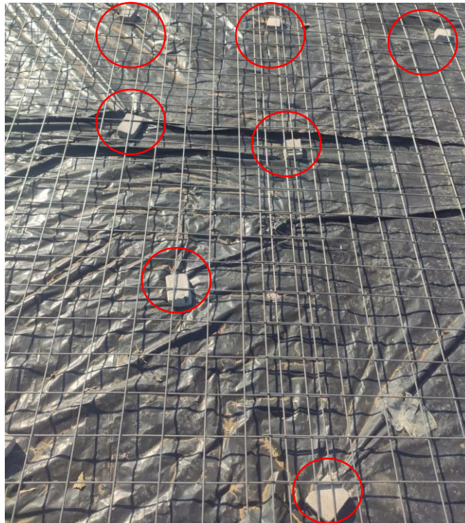
Figura 10 - Espaçadores artesanais feitos a partir de argamassa
