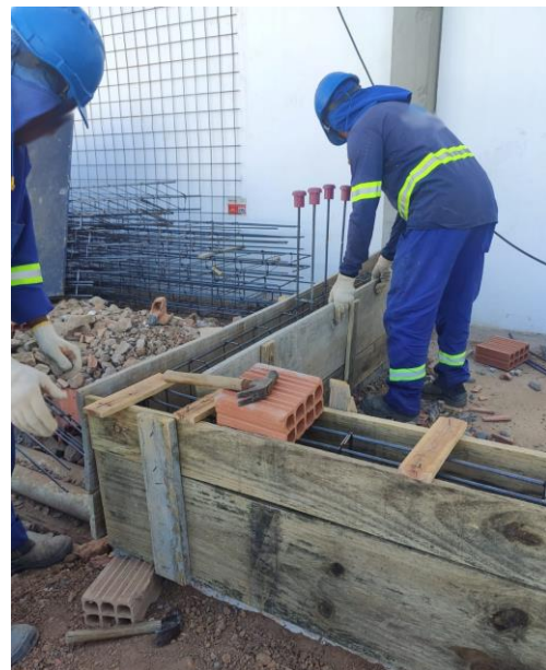
Figura 36 - Colaborador colocando a fôrma lateral da baldrame
