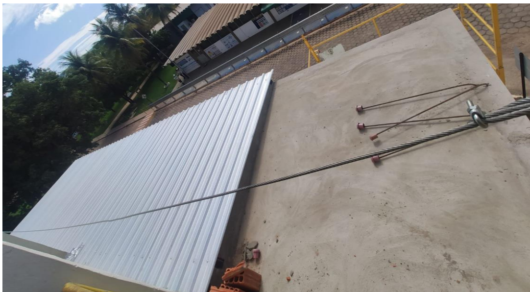
Figura 64 - Parte da laje com presença de cobertura e a outra impermeabilizada
