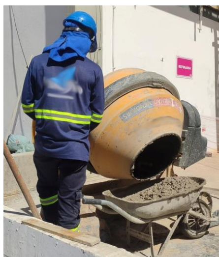
Figura 49 - Concreto confeccionado em betoneira e transportado por carrinho de mão
