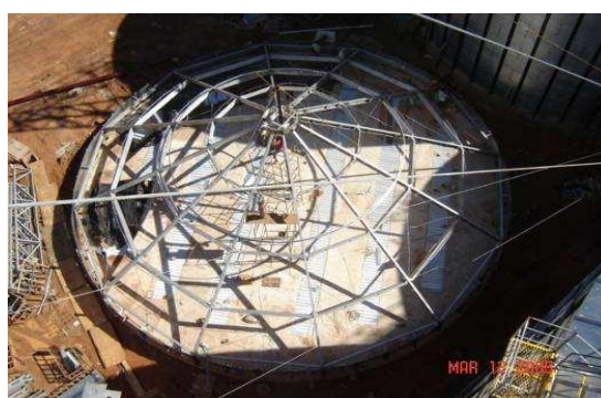
Figura 27 - Telhados com estrutura de suporte de silo
