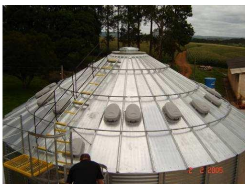
Figura 26 - Telhados autoportantes de silo
