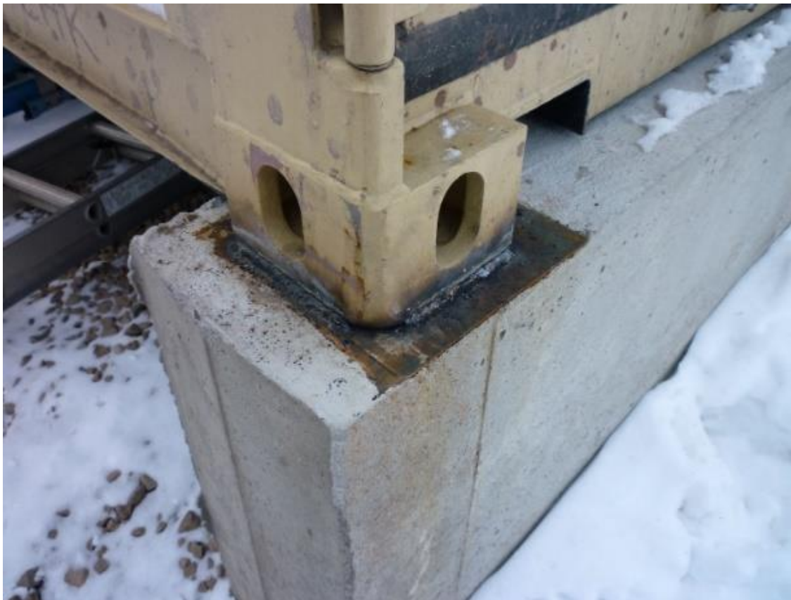
Figura 9 - Contêiner soldado à fundação.
