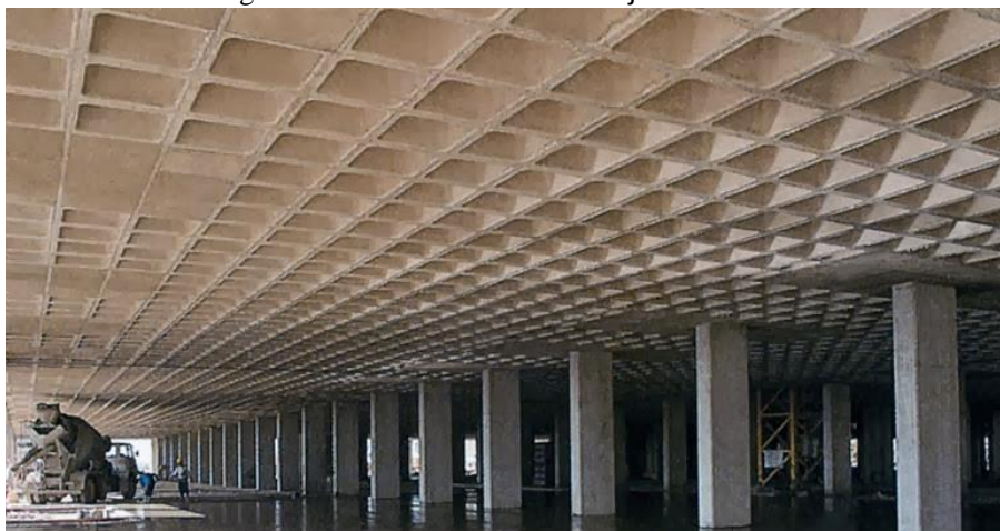
Figura 7 - Vista de uma laje nervurada.
