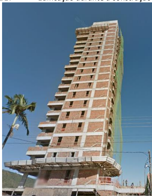
Figura 27 - Edificação durante a construção.
