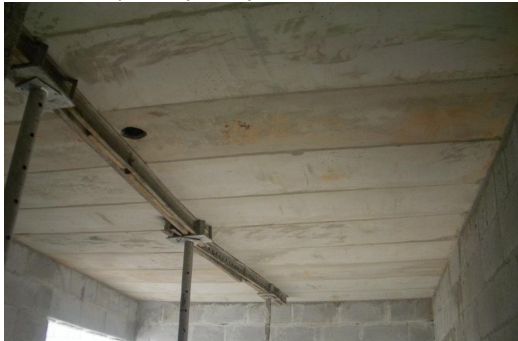
Figura 6 - Exemplo de laje maciça convencional ainda com escoramento.
