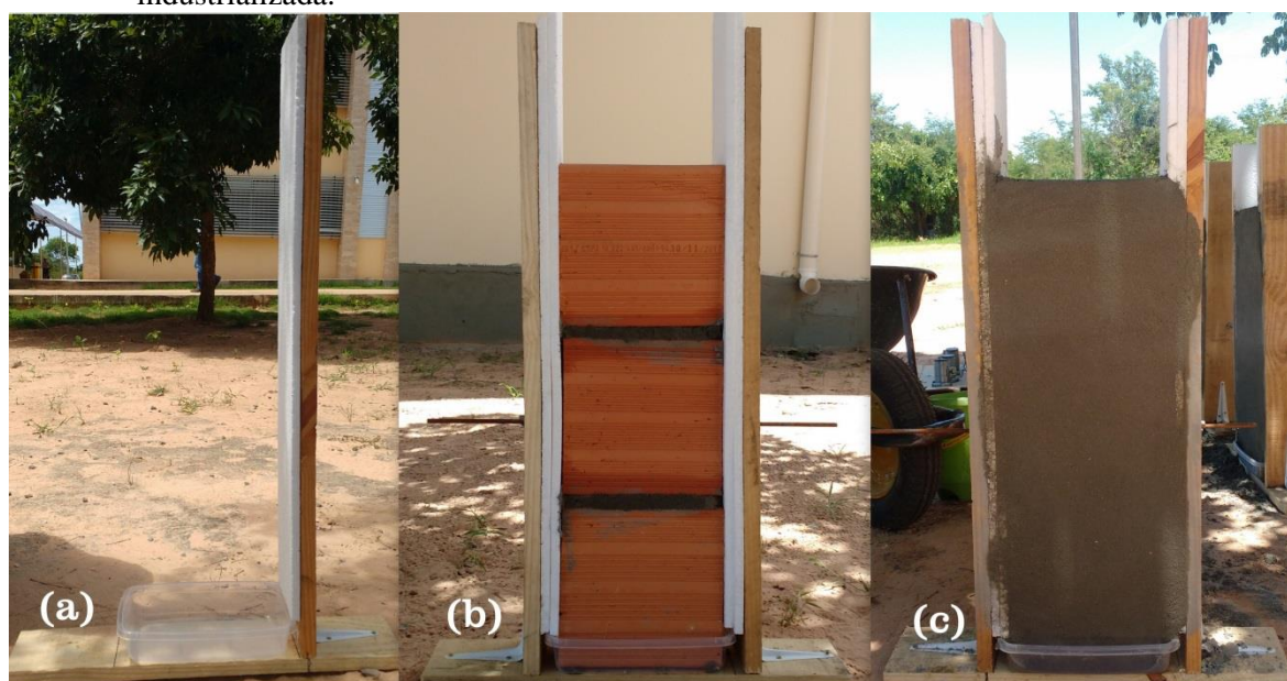
Figura 14 – Processo construtivo do protótipo: (a) Estrutura de madeira e recipiente plástico, (b) assentamento dos blocos e (c) revestimento de uma face da parede com argamassa industrializada.
