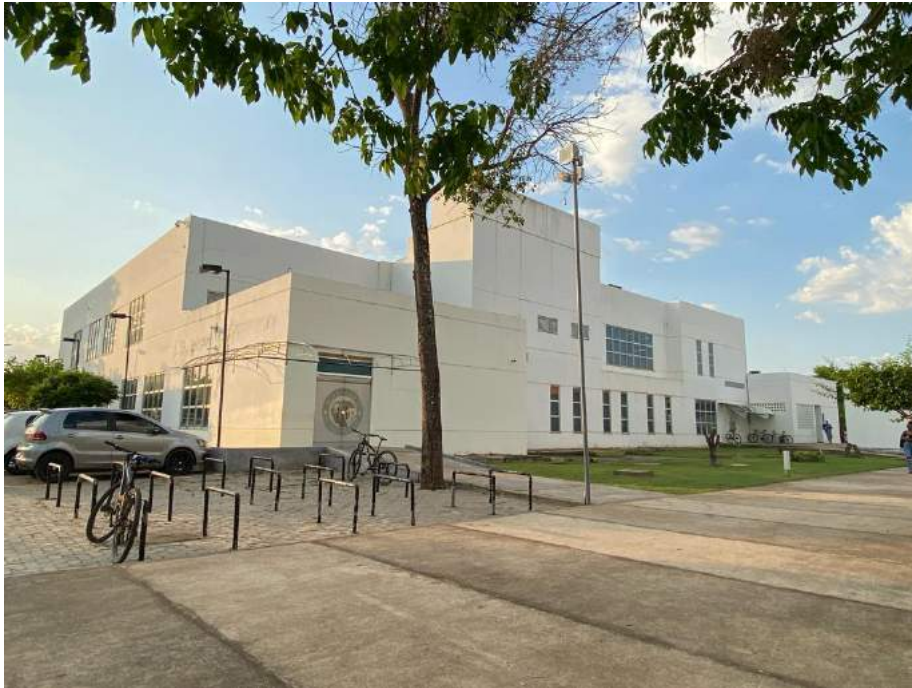
Figura 22: Museu e Biblioteca, área a ser impermeabilizada no teto
