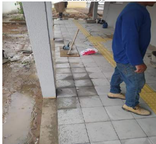
Figura 19: Assentamento de Ladrilhos Hidráulicos
