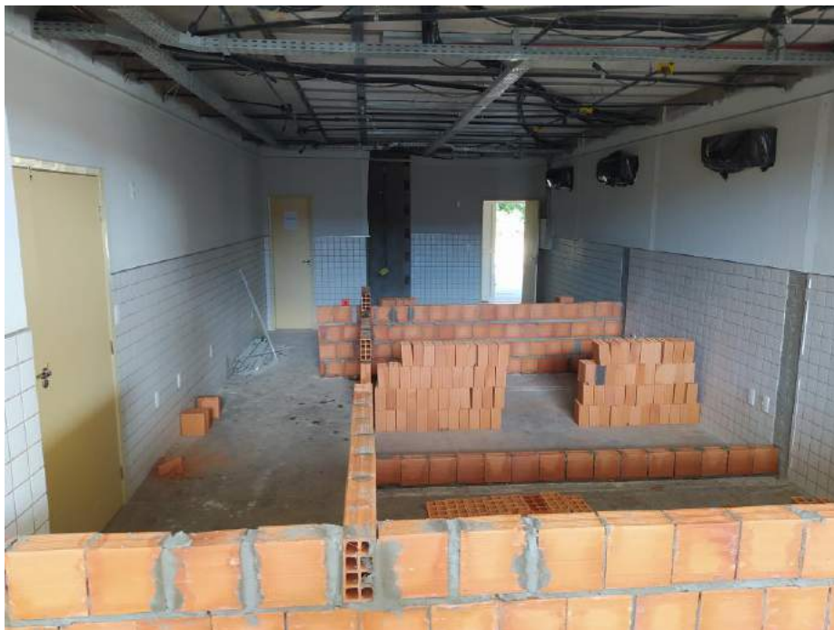
Figura 23: Levantamento de Alvenaria para isolamento físico e acústica das salas da Psicologia
