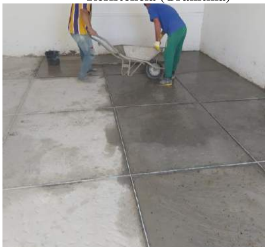
Figura 18: Execução de Piso de Alta Resistência (Granitina)
