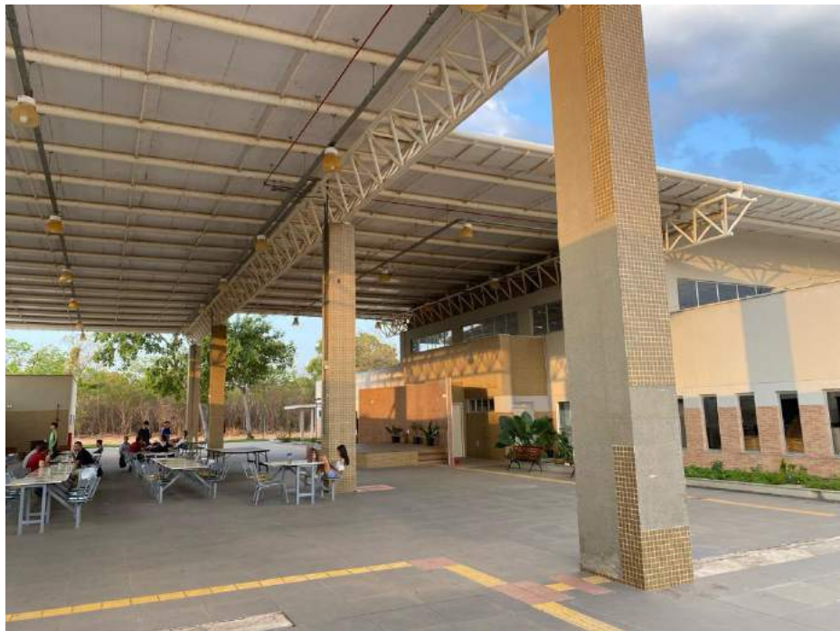
Figura 21: Centro de Vivência, manutenção do revestimento dos pilares e demais serviços
