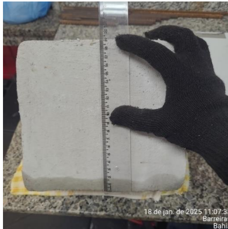
Figura 35 - Aferição da altura da mancha de umidade no bloco com régua
