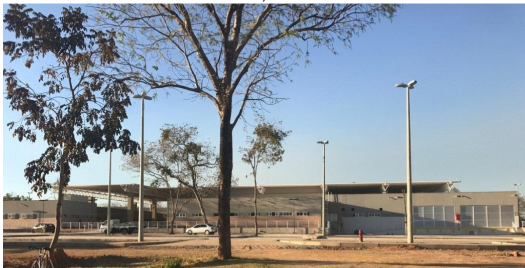
Figura 13: Fachada do RU e Centro de Convivência, em Barreiras.
