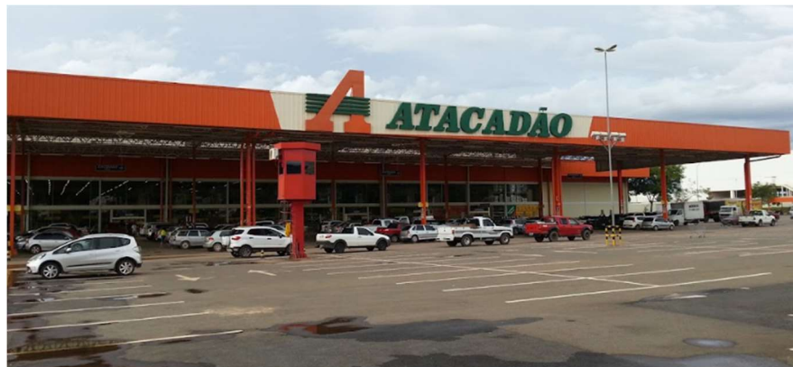
Figura 27: Estacionamento Supermercado Atacadão
