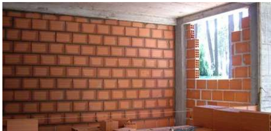
Figura 2 – Alvenaria de vedação tradicional
