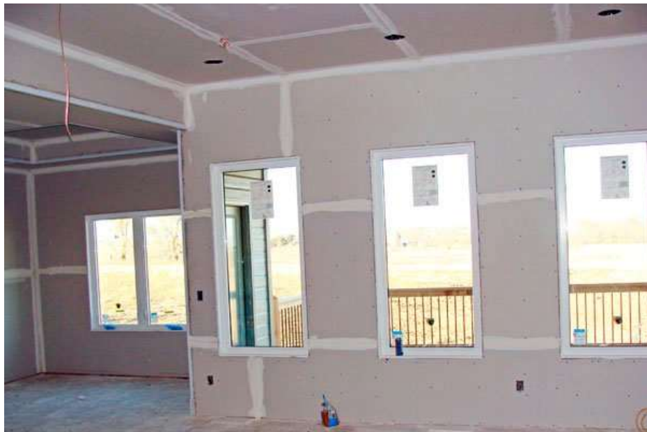
Figura 3 – Vedação em drywall
