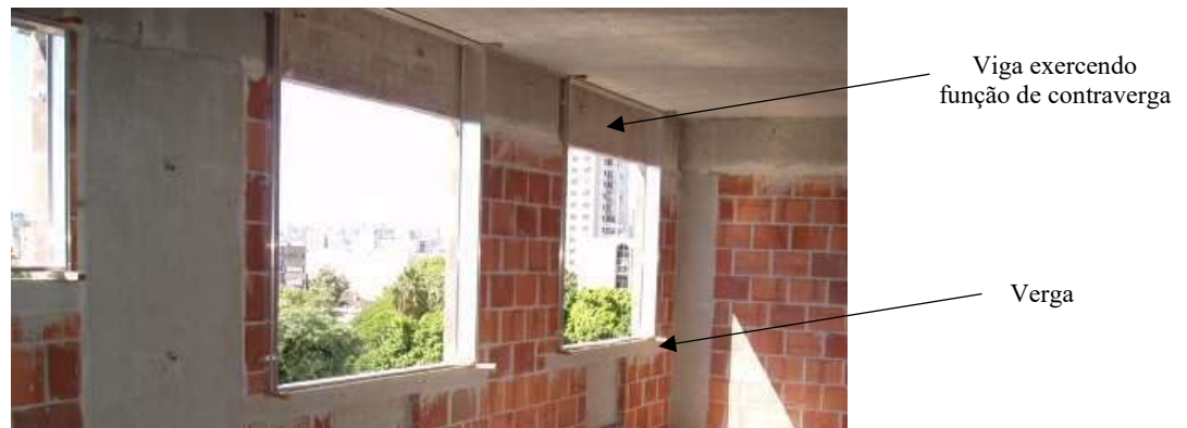
Figura 12 – Execução de vergas
