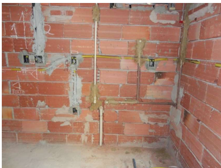
Figura 8 – Rasgos em alvenaria para embutimento de instalações
