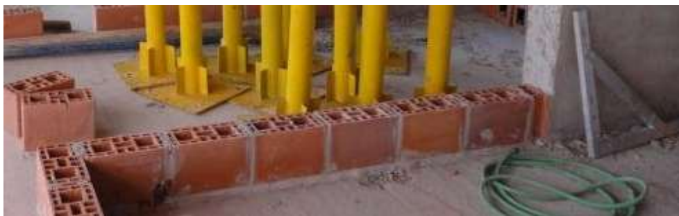
Figura 9 – Execução da primeira fileira de blocos cerâmicos
