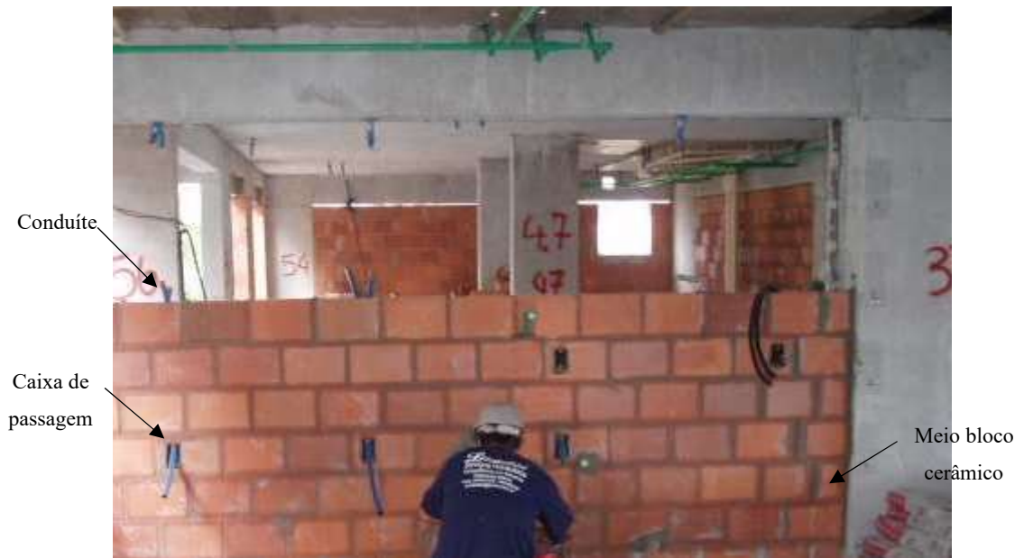
Figura 4 – Alvenaria racionalizada e a estrutura
