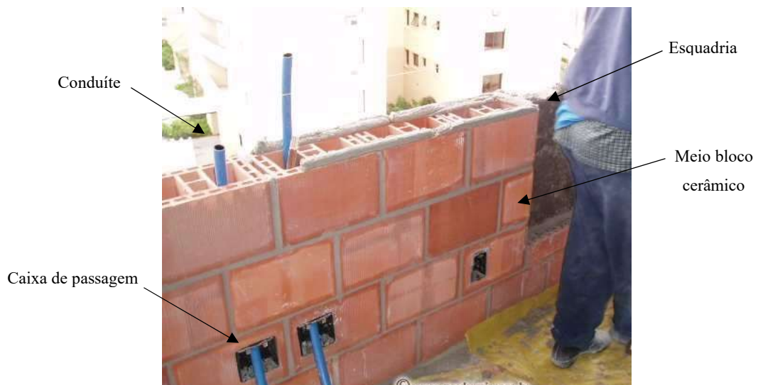
Figura 5 – Alvenaria racionalizada e as esquadrias
