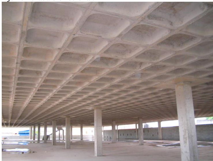
Figura 9 – Laje nervurada bidirecional.
