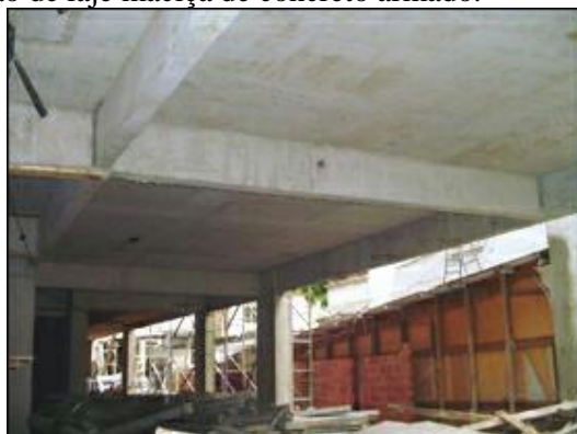
Figura 5 – Disposição de laje maciça de concreto armado.
