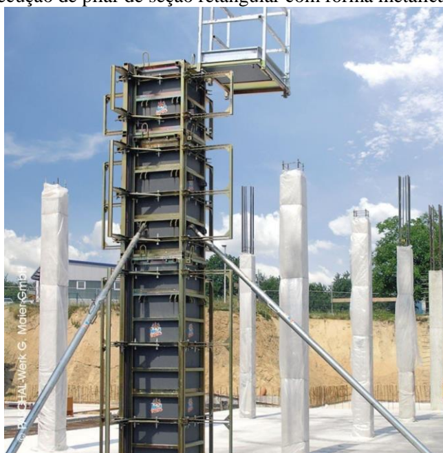
Figura 13 – Execução de pilar de seção retangular com fôrma metálica.
