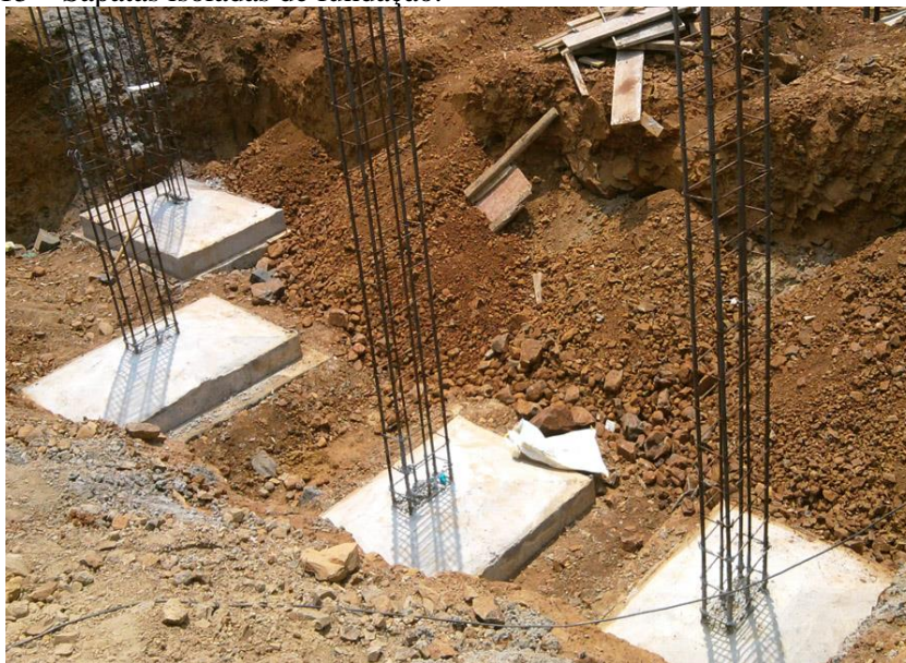
Figura 15 – Sapatas isoladas de fundação.
