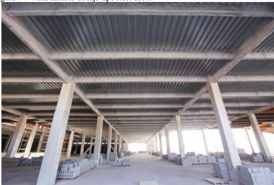
Figura 7 – Vista inferior de laje tipo steel deck .
