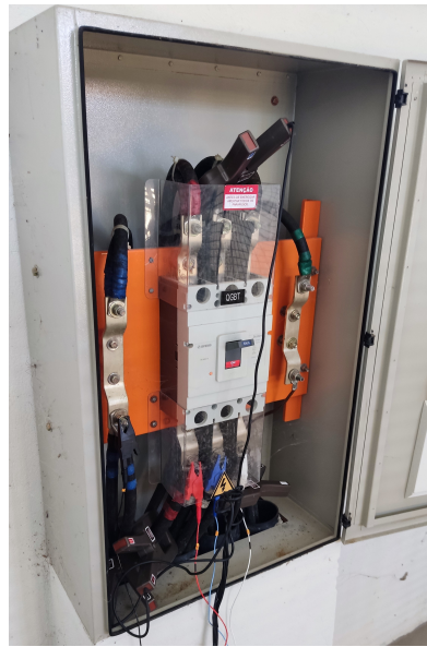
Figura 14 – Analisador P55 conectado ao QGBT 1
