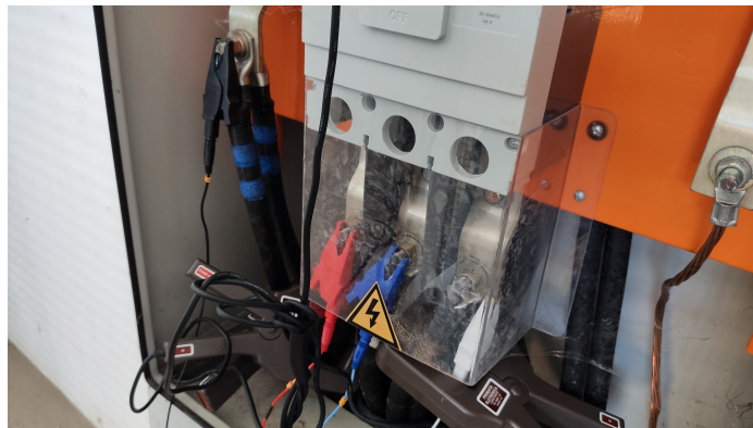
Figura 16 – Garras jacaré-golfinho conectadas ao QGBT 1
