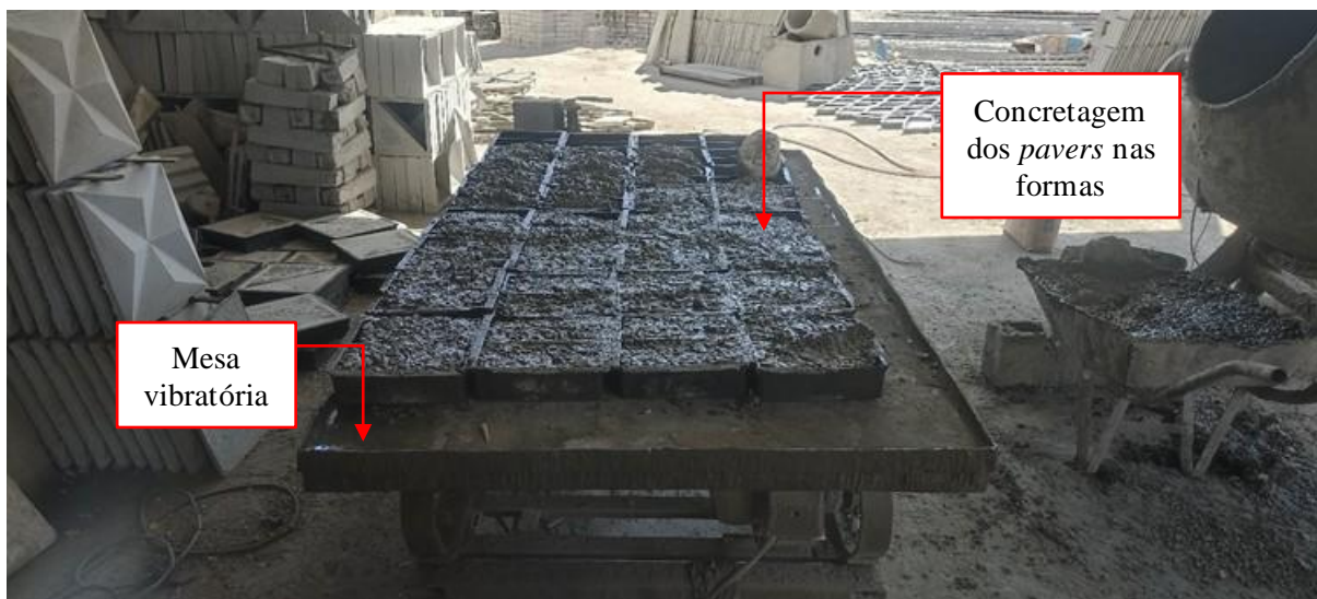
Figura 7: Registro fotográfico de preparação para moldagem das peças em mesa vibratória.
