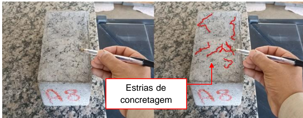
Figura 24: Identificação de defeito visual com padrões que se assemelha a estrias de concretagem.
