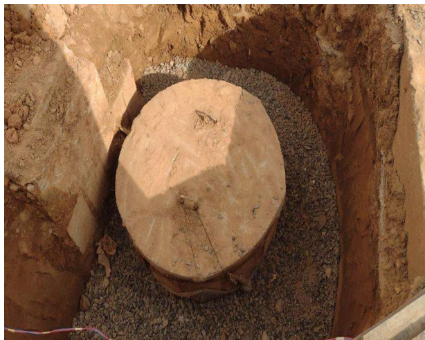
Figura 30: Execução de drenagem de sumidouro.
