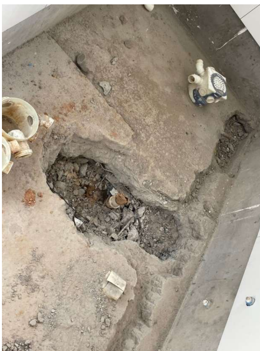
Figura 34: Bacia sanitária: Instalação contrapiso do banheiro.
