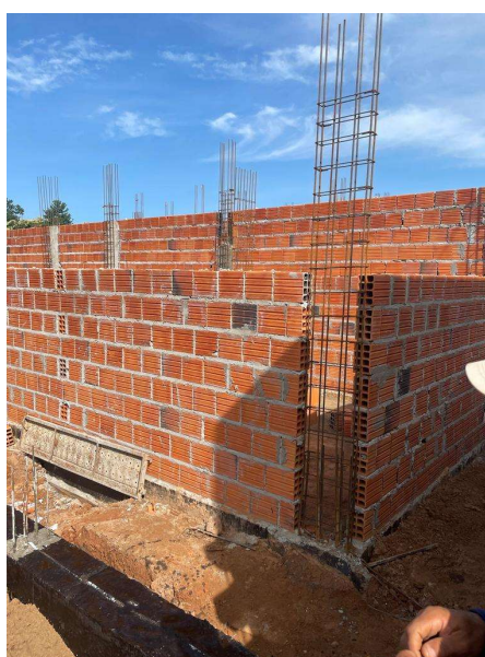
Figura 27: Método construtivo em alvenaria cerâmica.
