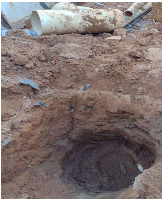
Figura 29: Escavação da fossa séptica.
