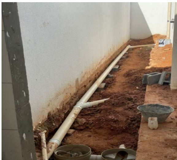
Figura 37: Correção da tubulação.
