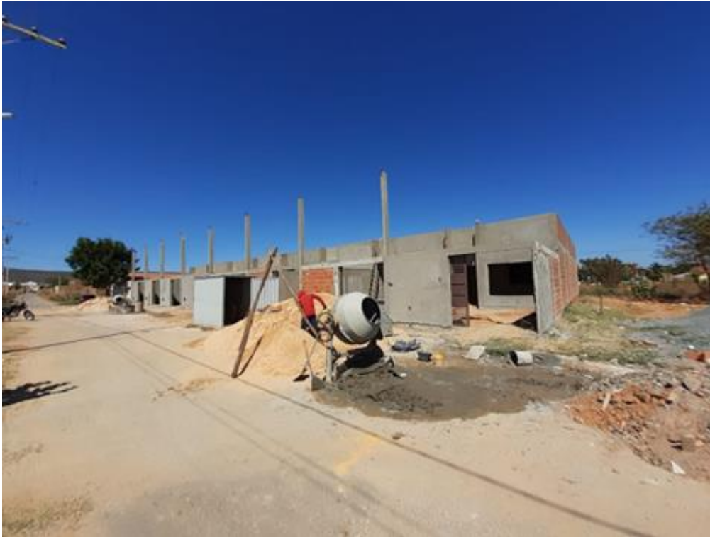
Figura 3.17 - Fachada da Obra 07 (em execução)
