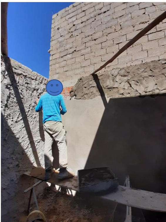
Figura 3.18 – Aplicação de Massa Única na Obra 07
