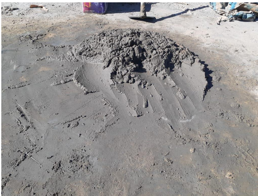
Figura 0.18 – Argamassa utilizada na aplicação de massa única na Obra 10
