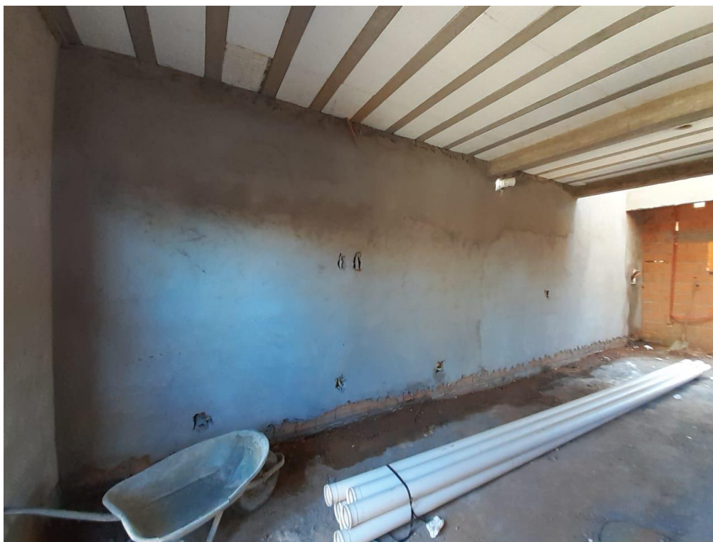
Figura 3.14 – Aplicação Interna de Massa Única na Obra 06
