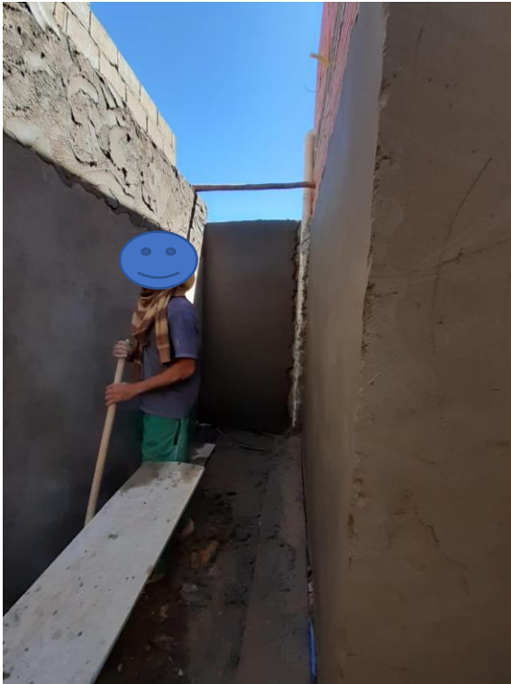
Figura 0.13 – Visão geral de aplicação de massa única na Obra 07
