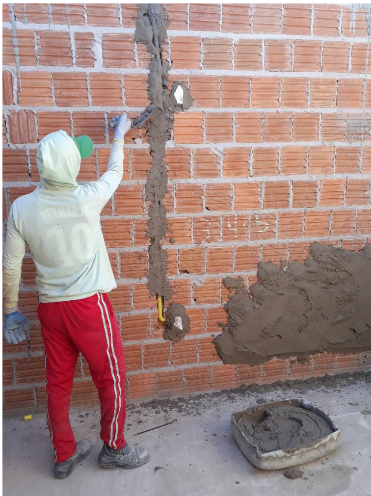
Figura 3.7 – Aplicação de Massa Única na Obra 03
