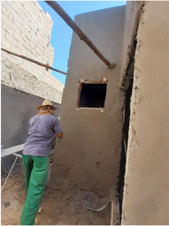
Figura 0.14 – Visão geral de aplicação de massa única na Obra 07
