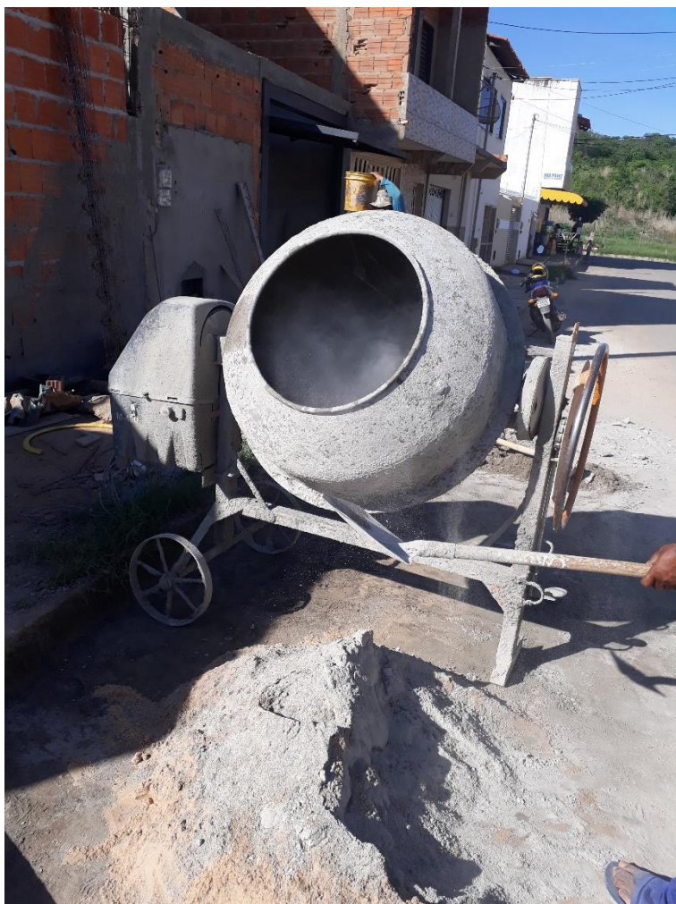
Figura 0.3 – Produção de Argamassa na Obra 03
