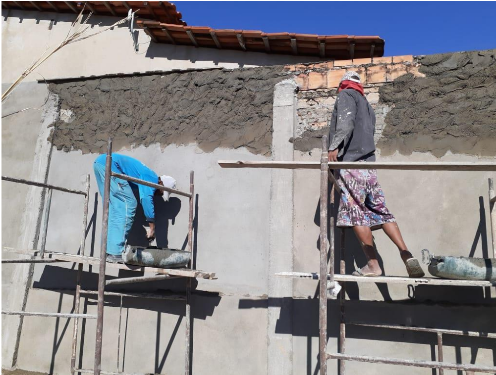
Figura 0.19 – Profissionais (pedreiro e servente prático) aplicando massa única na Obra 10
