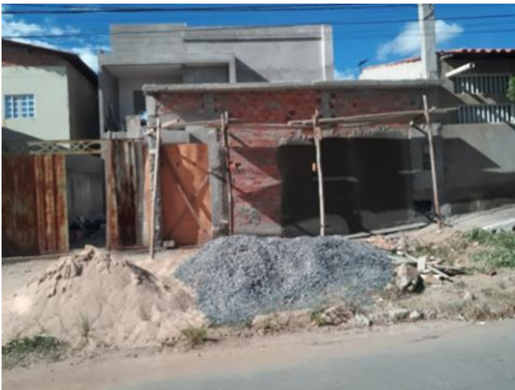
Figura 3.2 – Aplicação de Massa Única na Obra 01
