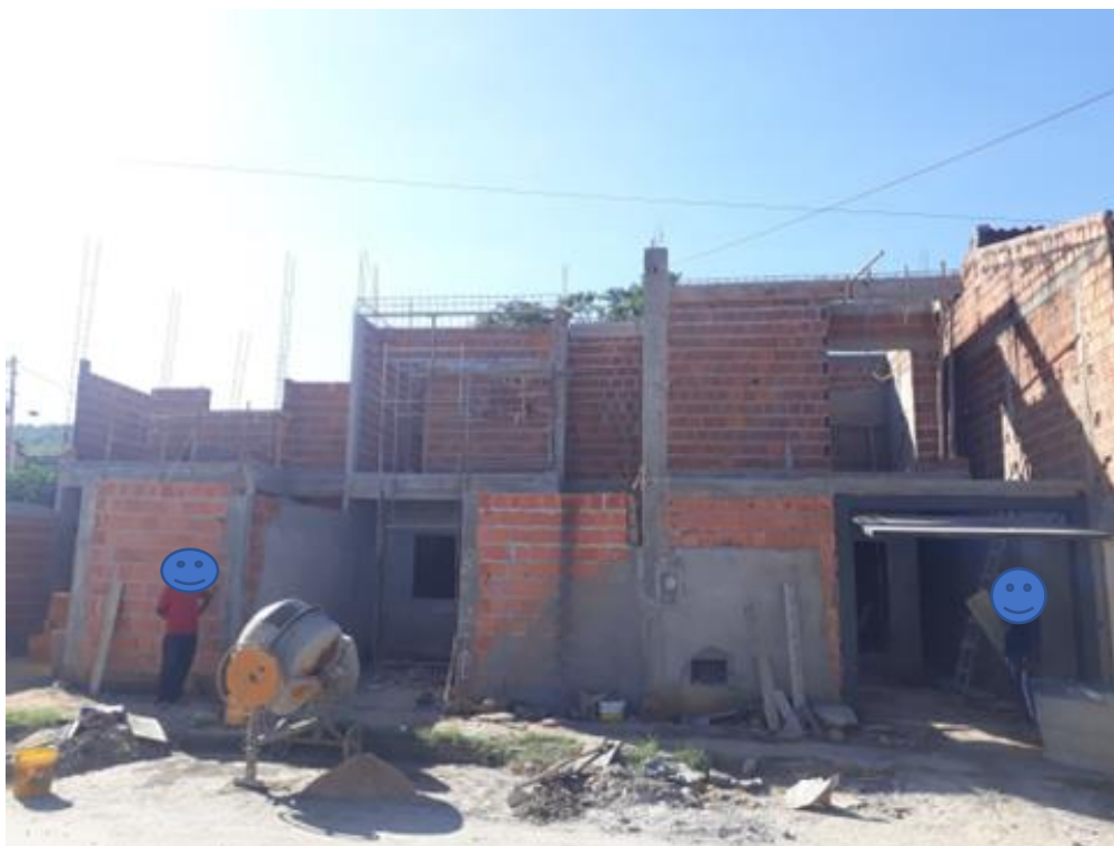
Figura 3.6 - Fachada da Obra 03 (em execução)
