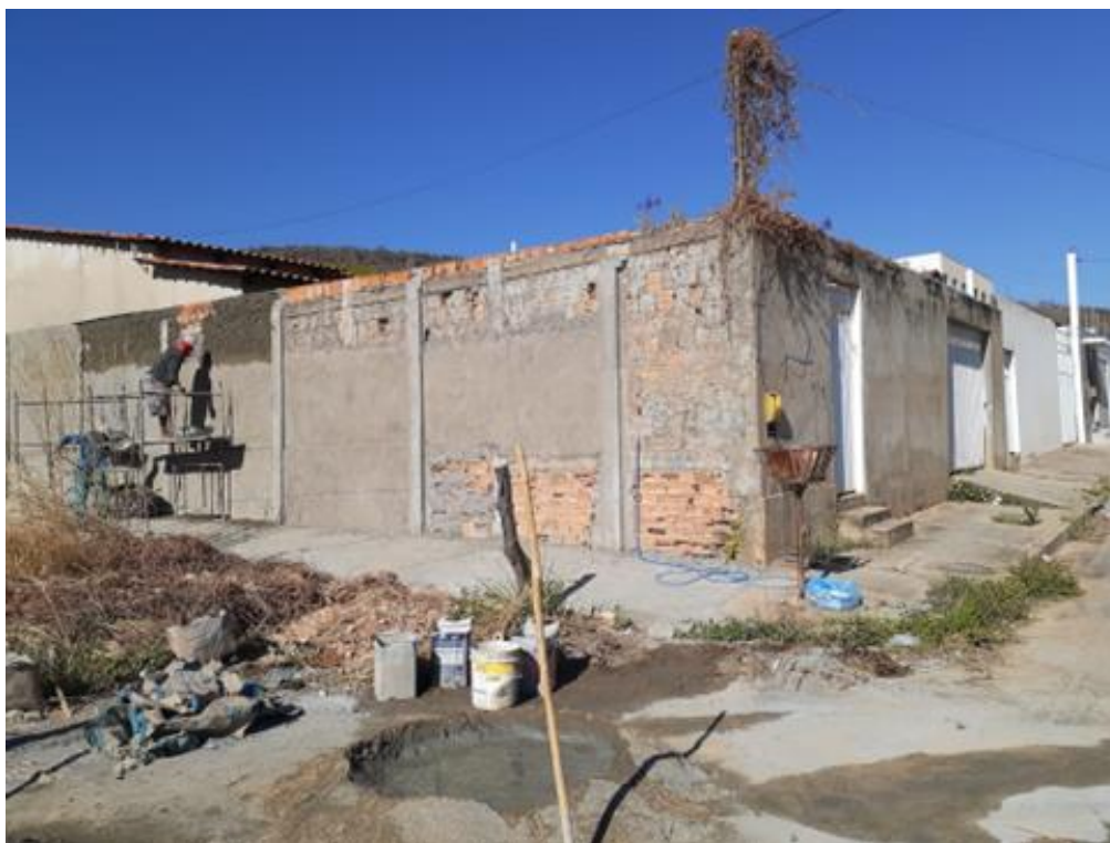
Figura 3.25 – Aplicação de Massa Única na Obra 10
