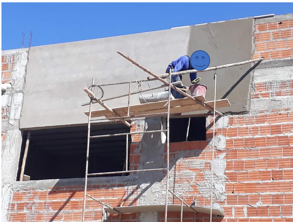
Figura 3.9 – Aplicação de Massa Única na Obra 04
