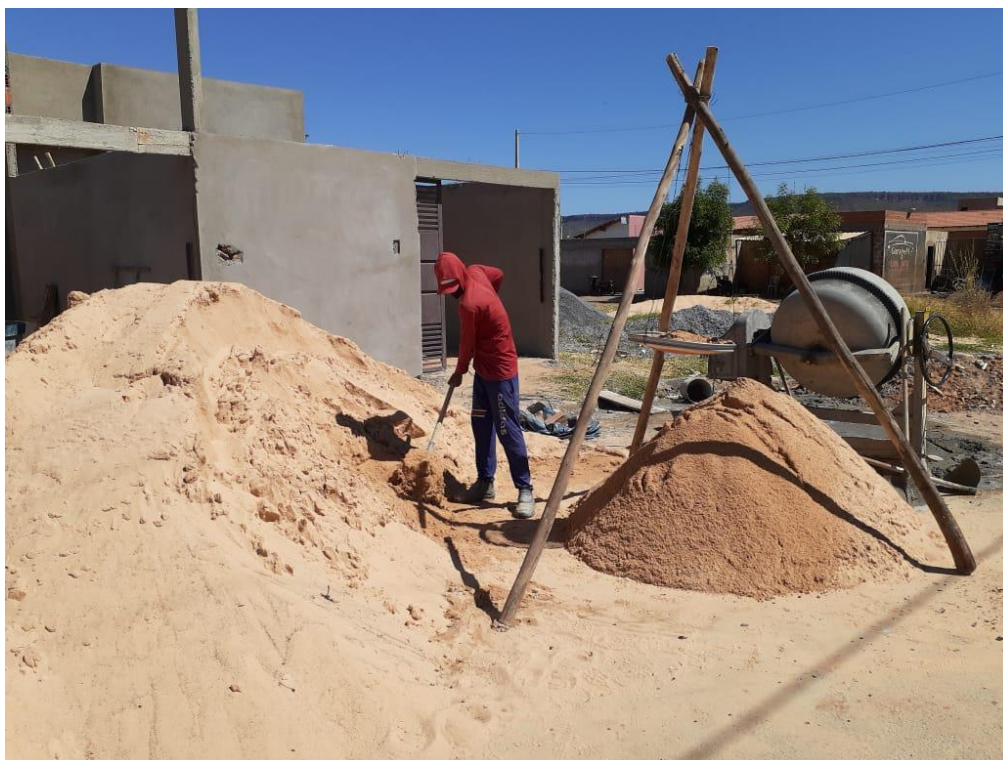
Figura 0.11 – Peneiramento de areia para confecção de argamassa na Obra 07
