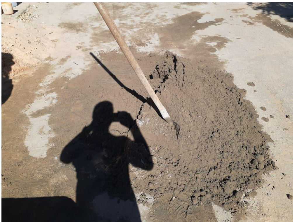
Figura 0.17 – Argamassa utilizada na aplicação de massa única na Obra 09
