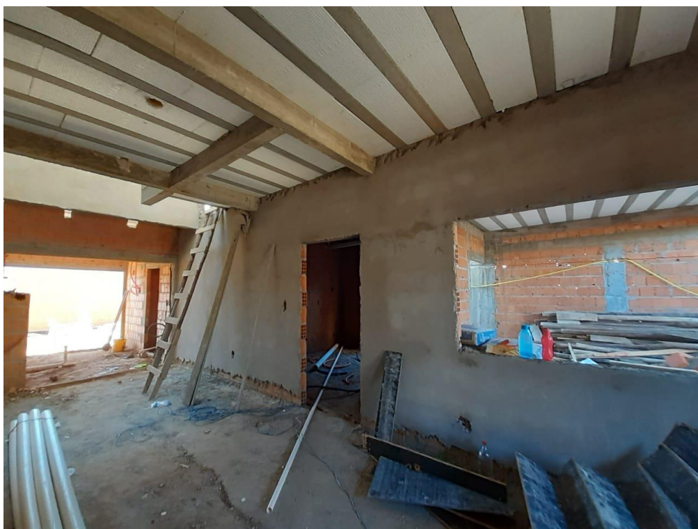
Figura 0.9 – Aplicação interna de massa única na Obra 06
