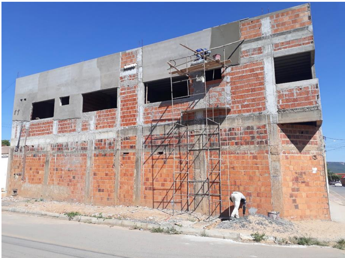
Figura 3.10 - Visão geral da parede de aplicação de massa única na Obra 04
