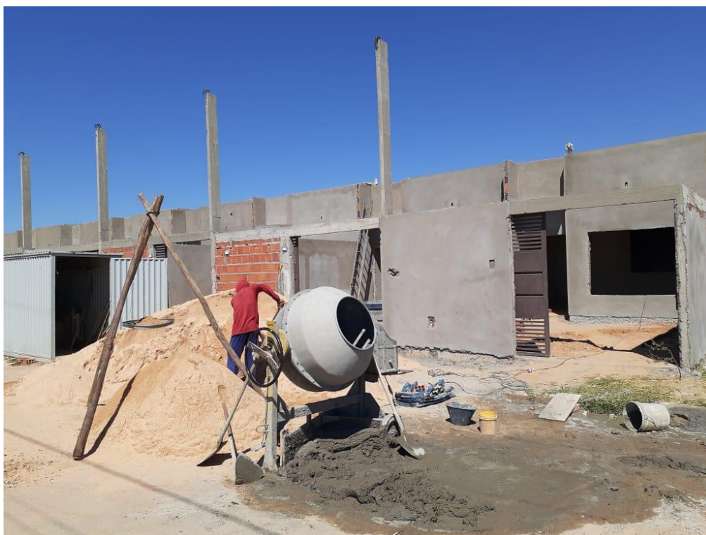
Figura 0.12 – Produção de argamassa na Obra 07
