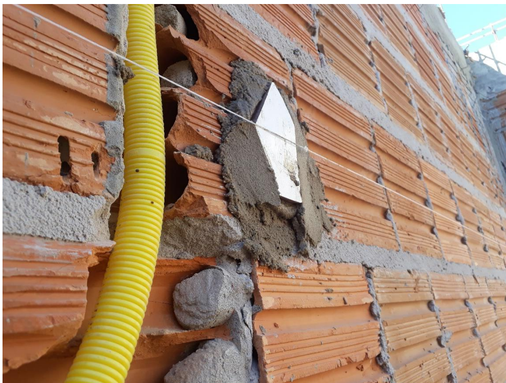
Figura 0.5 – Colocação de taliscas e passagem de eletrodutos na Obra 03
