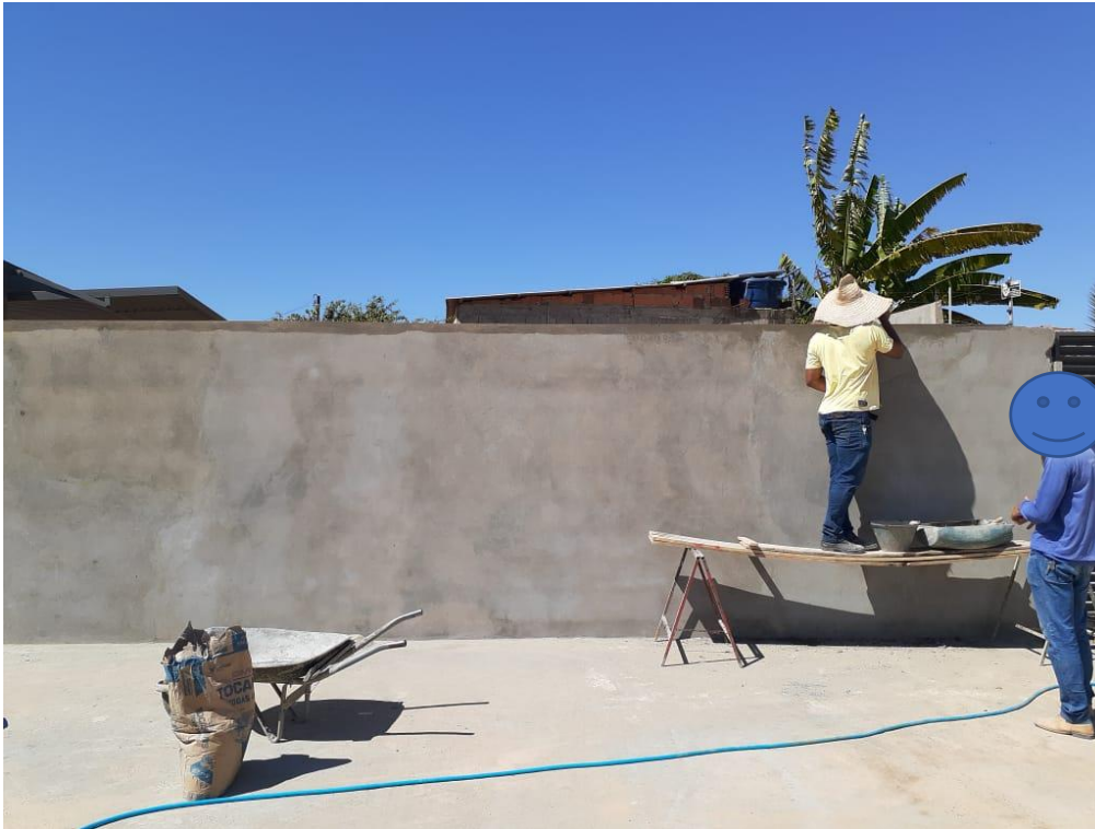
Figura 0.16 – Acabamentos finais após aplicação da massa única na Obra 08
