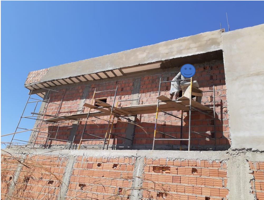
Figura 0.10 – Aplicação externa de massa única na Obra 06
