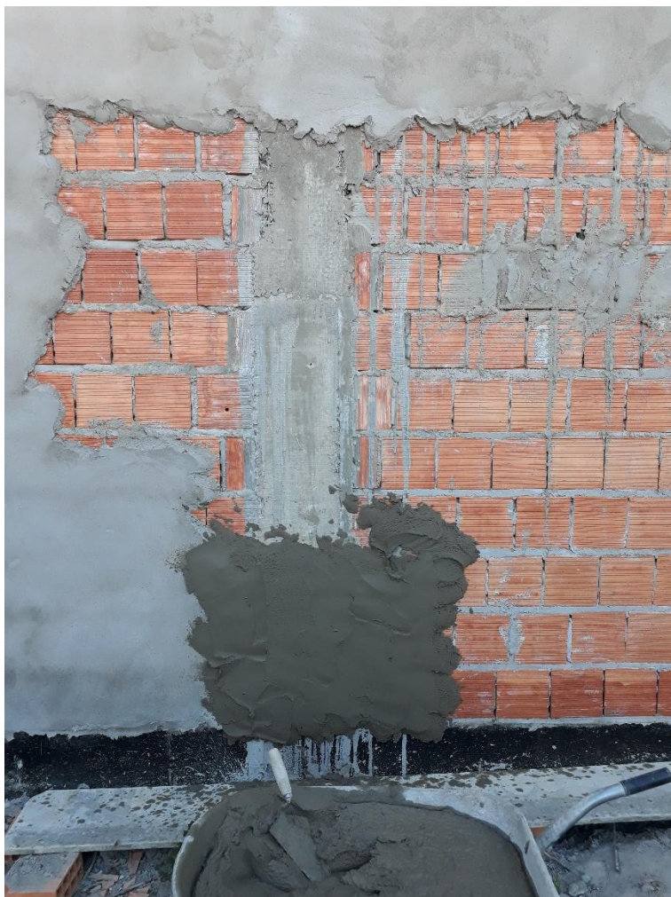
Figura 3.4 – Aplicação de Massa Única na Obra 02
