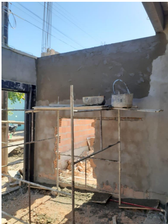
Figura 3.23 – Aplicação de Massa Única na Obra 09
