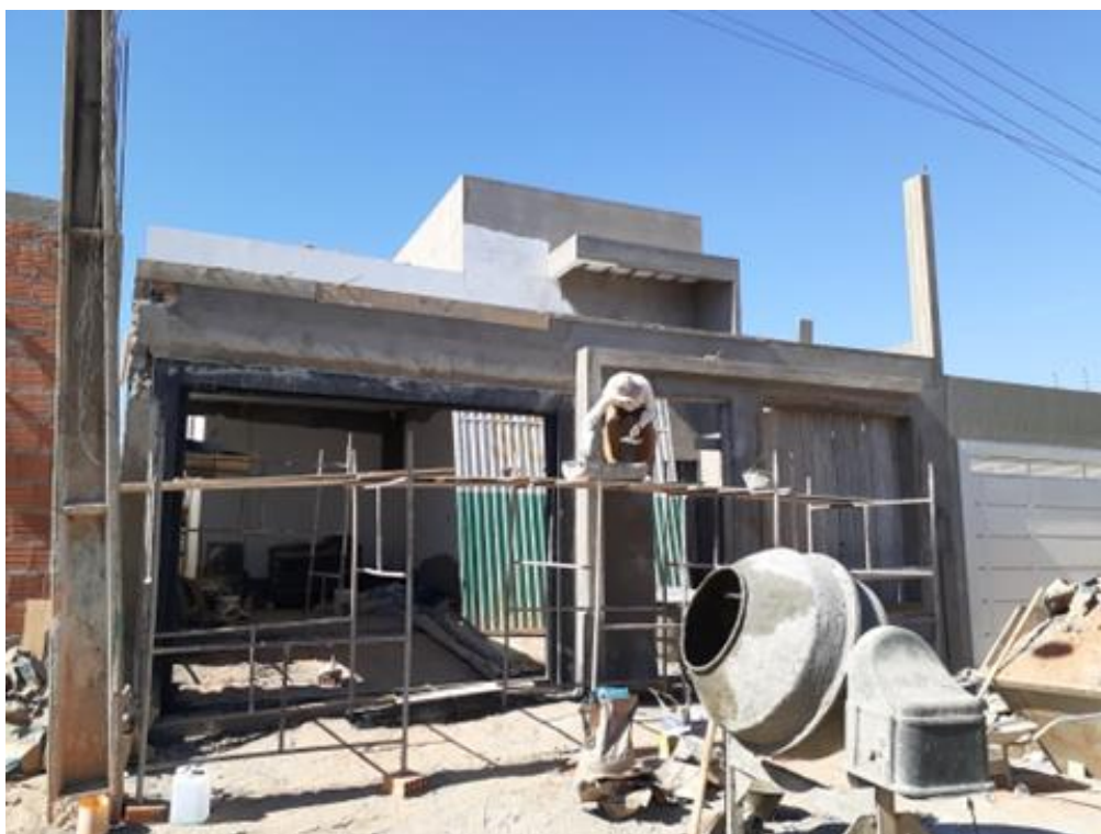
Figura 3.22 - Fachada da Obra 09 (em execução)
