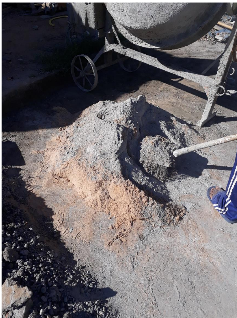
Figura 0.2 – Mistura dos insumos para confecção da Argamassa na Obra 03
