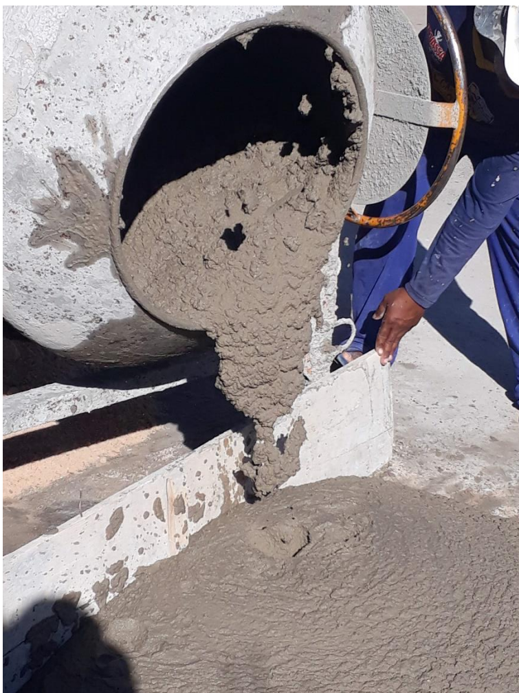
Figura 0.4 –Argamassa utilizada nas aplicações da Obra 03
