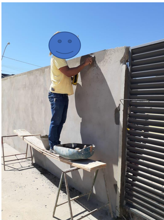
Figura 3.20 – Aplicação de Massa Única na Obra 08
