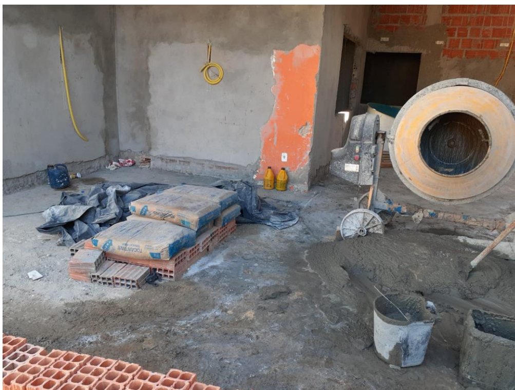
Figura 0.6 – Produção de argamassa na Obra 05
