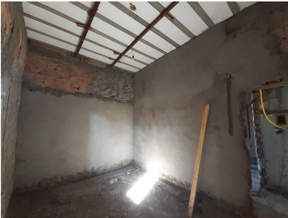
Figura 3.12 – Aplicação de Massa Única na Obra 05
