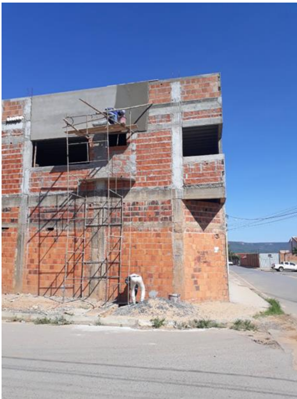
Figura 4.1 - Transporte Vertical na Obra 07
