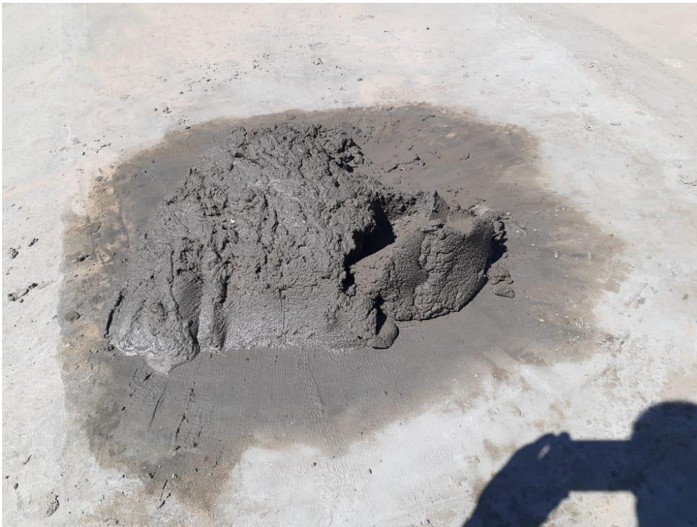
Figura 0.15 – Produção de argamassa na Obra 08
