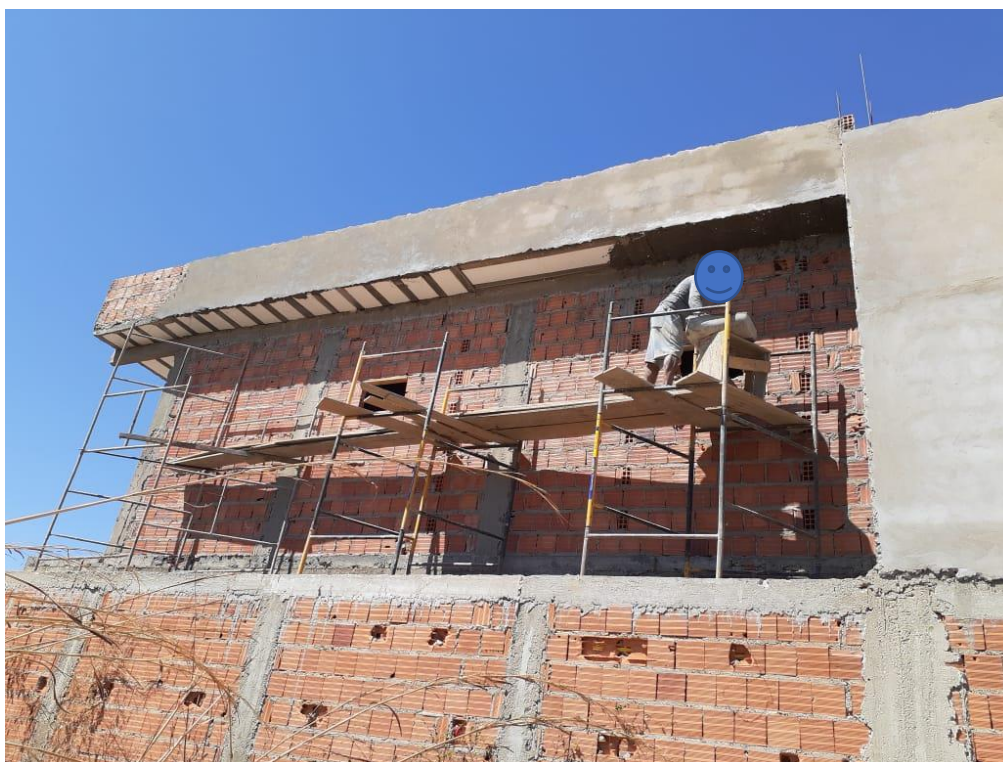
Figura 3.15 – Aplicação Externa de Massa Única na Obra 06
