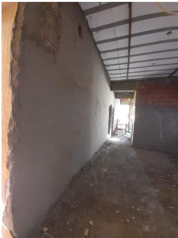
Figura 0.7 – Paredes com aplicação de massa única na Obra 05
