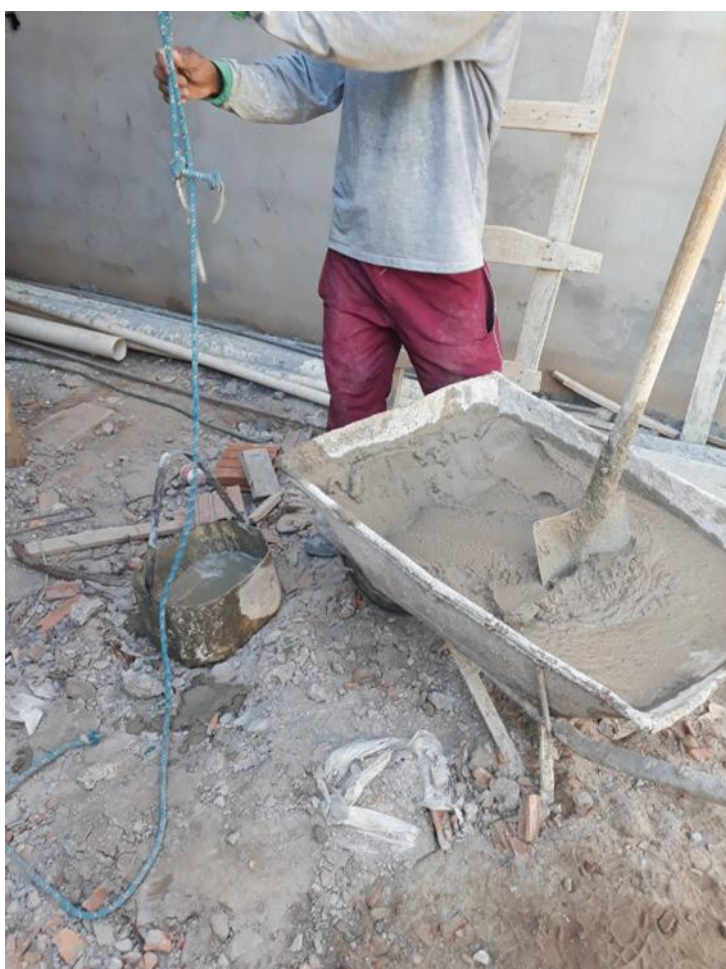
Figura 4.3 - Transição do Transporte Horizontal para o Vertical na Obra 04
