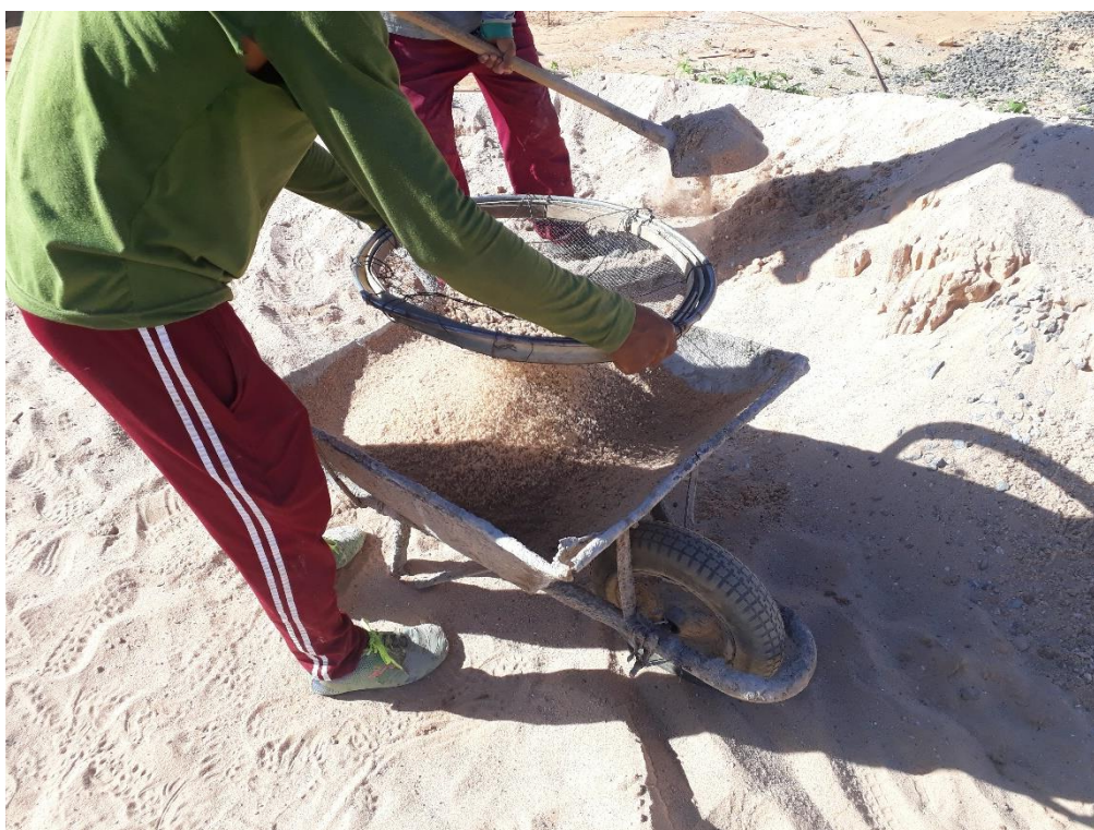
Figura 0.1 – Peneiramento da Areia na Obra 03
