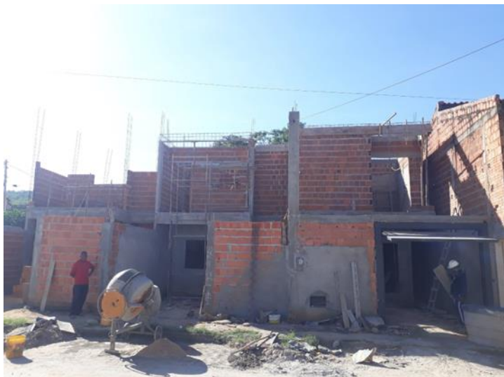
Figura 4.2 - Transporte Horizontal na Obra 04
