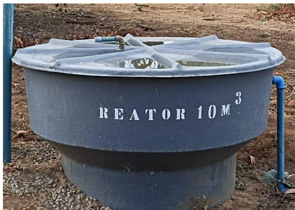
Figura 12- REATOR UASB
