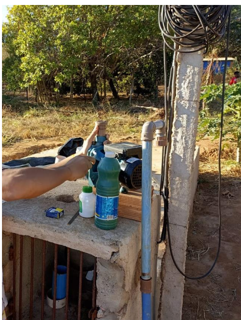
Figura 13- Manutenção realizada na bomba
