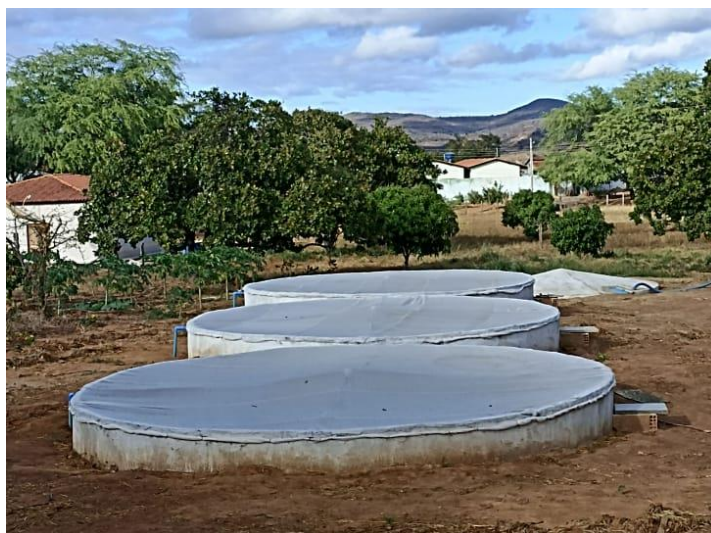
Figura 11- Lagoas de Polimento- tratamento solar das águas residuárias.
