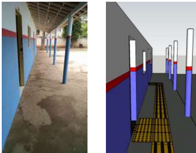
Figura 37 - Detalhe do corredor externo para acesso as salas e solução proposta.
