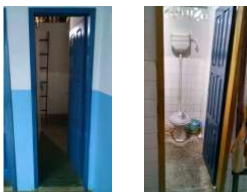
Figura 53 - Instalações sanitárias junto à circulação principal. Vista externa e interna do sanitário.
