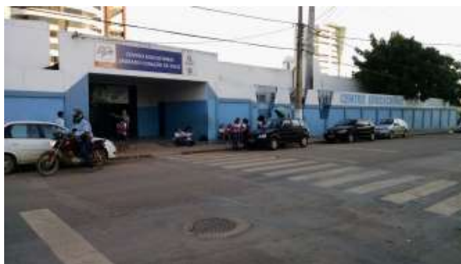
Figura 42 - Vista frontal da Escola 02
