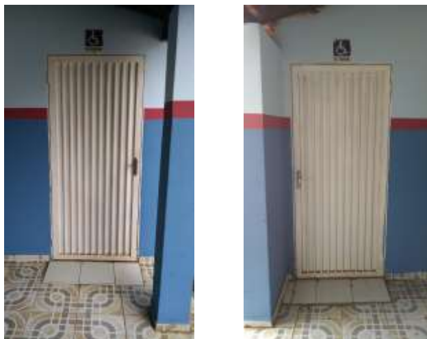
Figura 28 - Vista frontal do acesso aos sanitários tidos acessíveis. Detalhe da aplicação do símbolo internacional de acesso.
