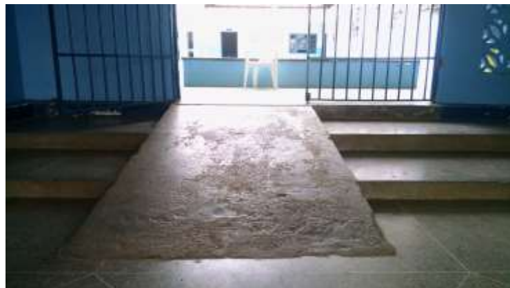
Figura 47 - Rampa de acesso ao corredor de circulação interna.
