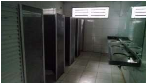
Figura 54 - Vista interna da instalação sanitária de uso coletivo.
