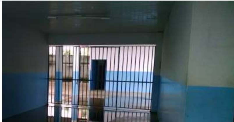
Figura 46 - Vista do corredor de acesso à área externa da escola.
