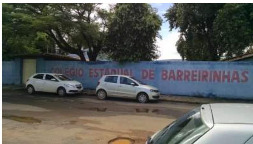
Figura 11 - Vista frontal da Escola 01.
