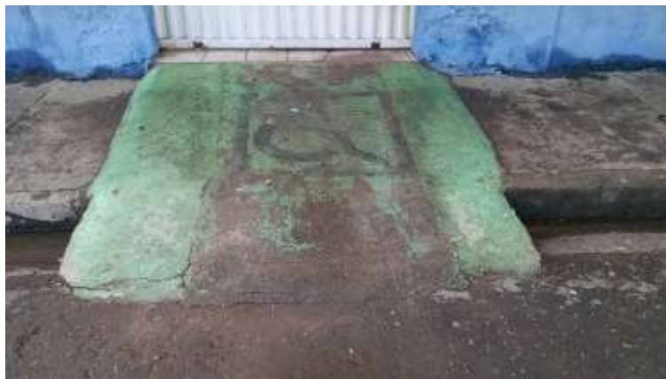
Figura 12 - Detalhe da calçada junto à rampa de acesso ao colégio.
