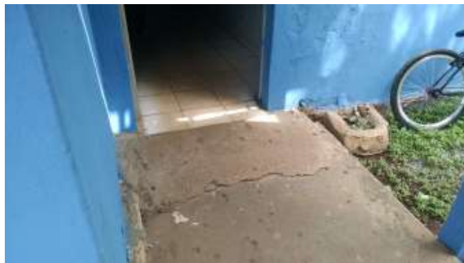
Figura 23 - Rampa vinculada ao corredor transversal. Acesso a área externa.
