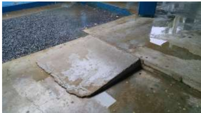
Figura 49 - Rampa de acesso a cantina da escola.
