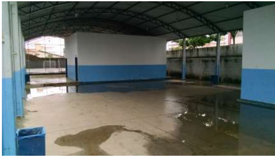
Figura 65 - Vista da área externa da escola. Ao centro da foto estão as instalações sanitárias de uso coletivo.
