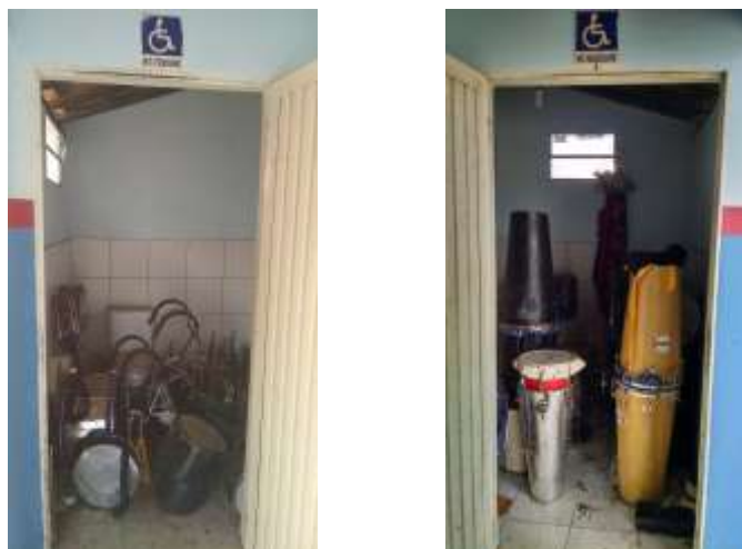
Figura 30 - Vista interna dos sanitários tidos acessíveis.
