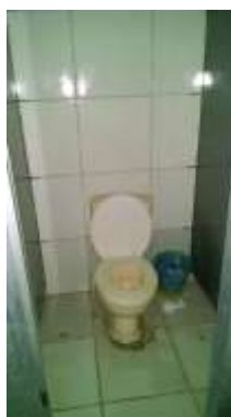
Figura 55 - Vista interna de uma das cabines do sanitário coletivo.
