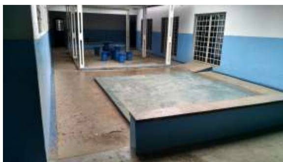
Figura 63 - Vista da rampa principal que dá acesso à biblioteca da escola.
