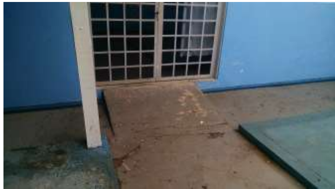
Figura 48 - Rampa de acesso ao auditório/biblioteca.
