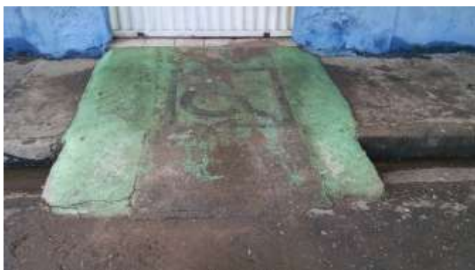
Figura 21 - Rampa localizada na entrada do colégio.
