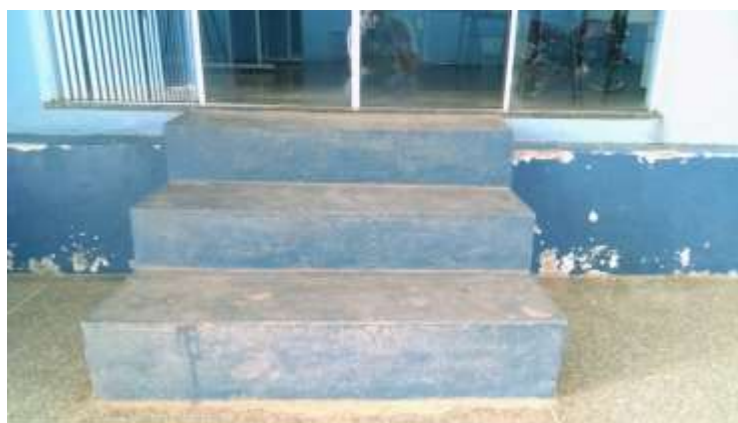
Figura 51 - Vista frontal da escada utilizada para acessar a secretária da escola.
