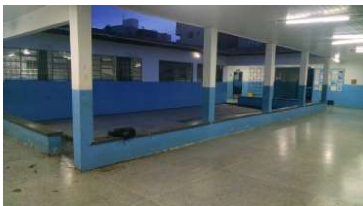
Figura 45 - Vista da principal circulação da escola.
